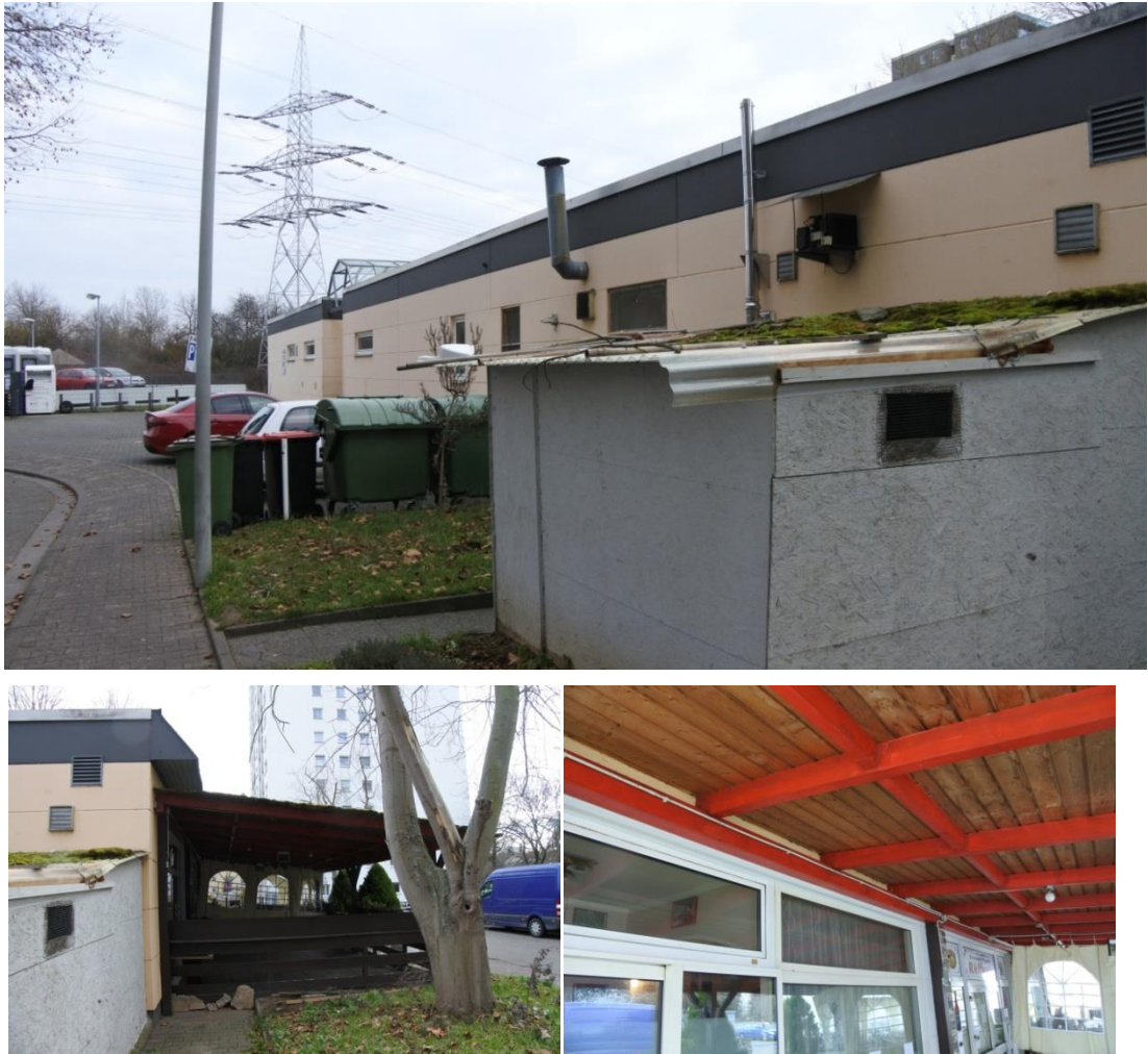
Abbildung 2: Gebäude Am sonnigen Hang 8 + 10 in Mainz. Oben: Nordfassade mit Glasüberbau und angrenzendem Gebäude Nr. 12. Unten: westlich anschließender Bereich einer überdachten Terrasse. Derzeit keine Hinweise auf eine Nutzung als Fortpflanzungs- und Ruhestätte. (Fotos: BG Natur).
