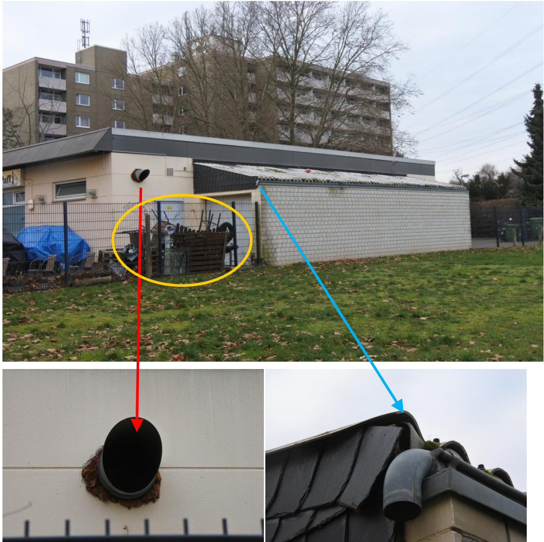
Abbildung 7: Gebäude Am sonnigen Hang 12 in Mainz. Oben: Ansicht der Ostfassade mit vorgelagerter Garage. Gelber Kreis: Stapel verschiedener Gegenstände. Darunter könnten sich Tiere aufhalten. Daher ist der Stapel im Falle von Gebäuderückbau vorher händisch abzuräumen. Unten links: Rohrdurchlass in Wand ist vergittert (roter Pfeil) und verhindert somit Einschlufl von Tieren; unten rechts: Übergang Dachziegel – Dach im Bereich des Regenrohrs: Potenzielle Einschluflmöglichkeit (blauer Pfeil) ohne Hinweise auf aktuelle oder vergangene Nutzung durch Tiere, z.B. Kot oder Nistmaterial, Foto: BG Natur).
