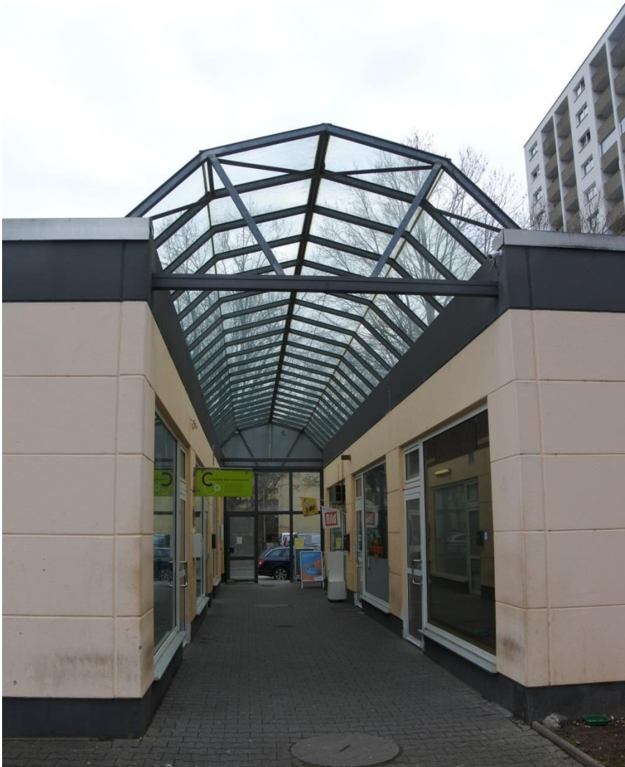
Abbildung 4: Gebäude Am sonnigen Hang 8 - 12 in Mainz. Glasüberbau zwischen den Gebäuden Nr. 8 + 10 und Gebäude Nr. 12. Derzeit keine Nutzung als Fortpflanzungs- und Ruhestätte erkennbar. Zukünftige Nutzung als solche ist jedoch nicht auszuschließen. Daher im Falle eines Gebäuderückbaus erneute Untersuchung der Bereiche durch Fachgutachter erforderlich. (Fotos: BG Natur).
