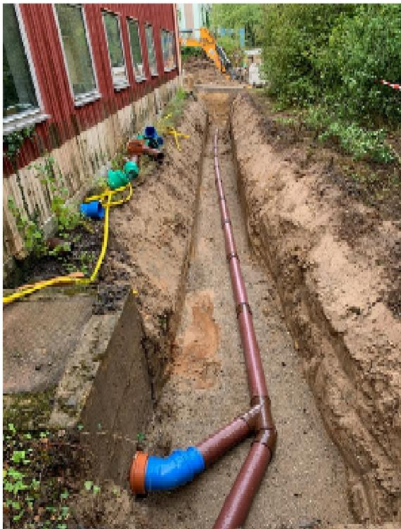
Außerdem erfolgte der Anschluss an die neuen Schmutz- und Regenwasserkanäle. Teilweise mussten dazu auch Entwässerungsleitungen auf den Grundstücken saniert bzw. komplett erneuert werden.
