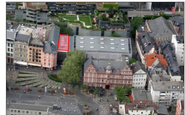
Mögliche Aufstellfläche Rückkühlung
