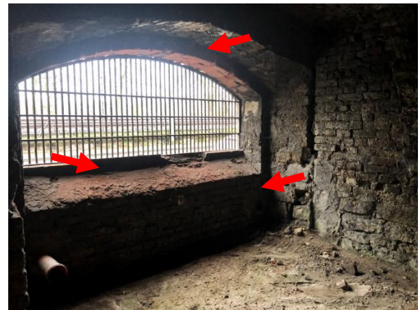
Bild 14: Keller 5, Abmauerung zur Wormser Straße
