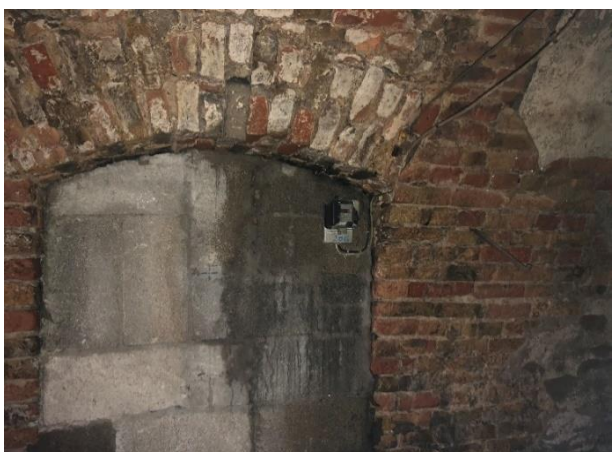
Bild 9: Vermauerter Durchgang zwischen Kellern
