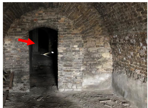
Bild 10: Keller 3 mit zusätzlichen Stützen
