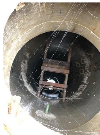
Bild 22: Tiefbrunnen IIa, Detail
