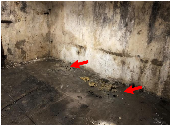
Bild 17: Geräumtes Gebindelager im Kellergang mit Bohrungen EK 1 und EK 2
