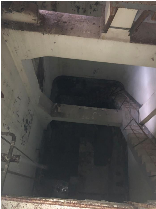
Bild 1: Blick in den Tiefkeller
