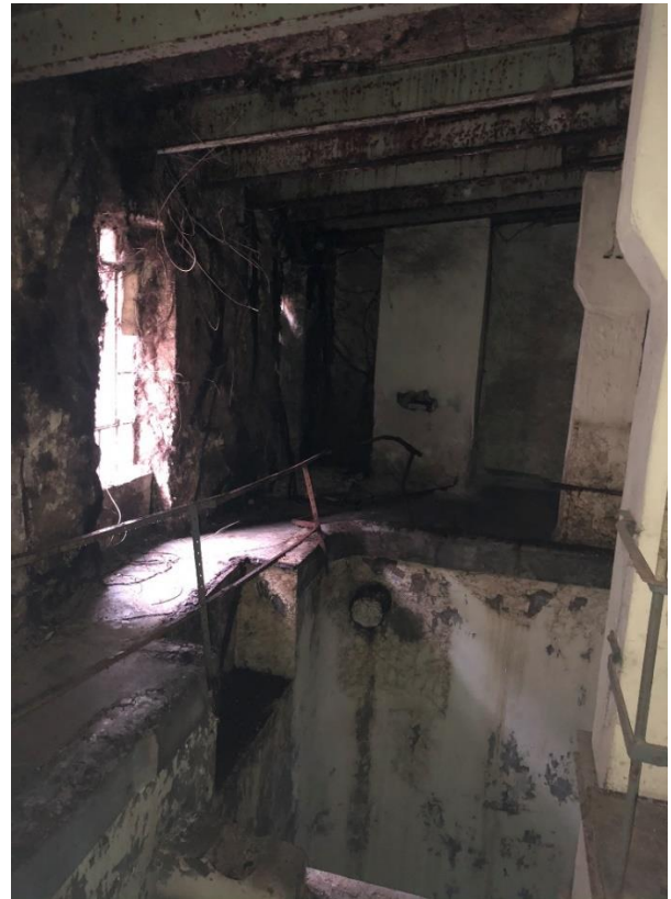
Bild 2: Pumpenhaus mit Tiefkeller
