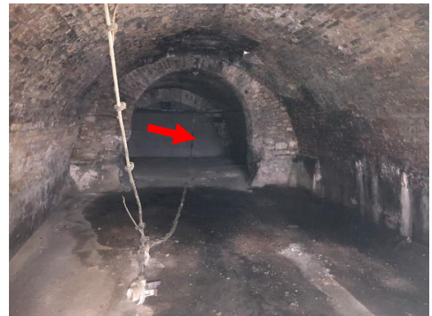
Bild 8: Keller 2 mit Abmauerung
