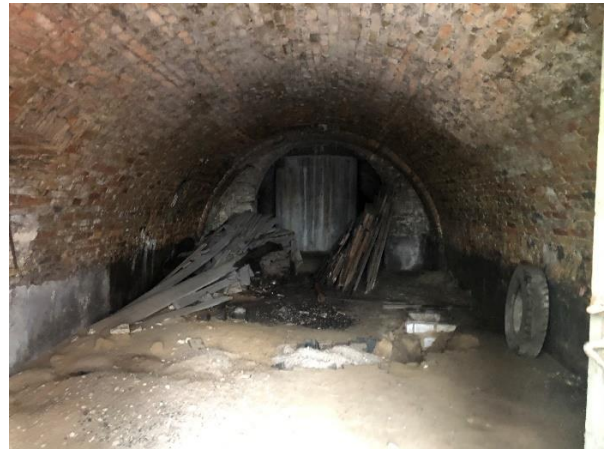
Bild 6: Keller 1 während Räumung, Abwasserbehälter
