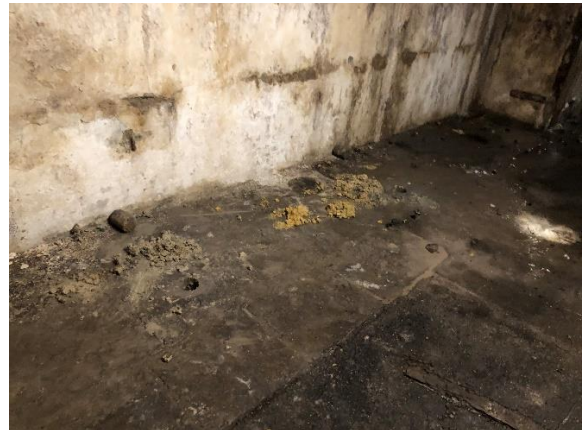
Bild 18: Geräumtes Gebindelager im Kellergang
