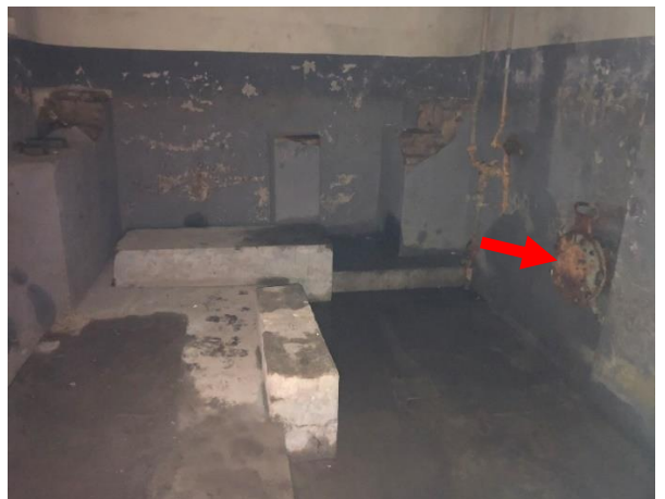
Bild 4: ehemalige Pumpenfundamente Tiefkeller, Pfeil: verm. Anschluß Brunnen IIa
