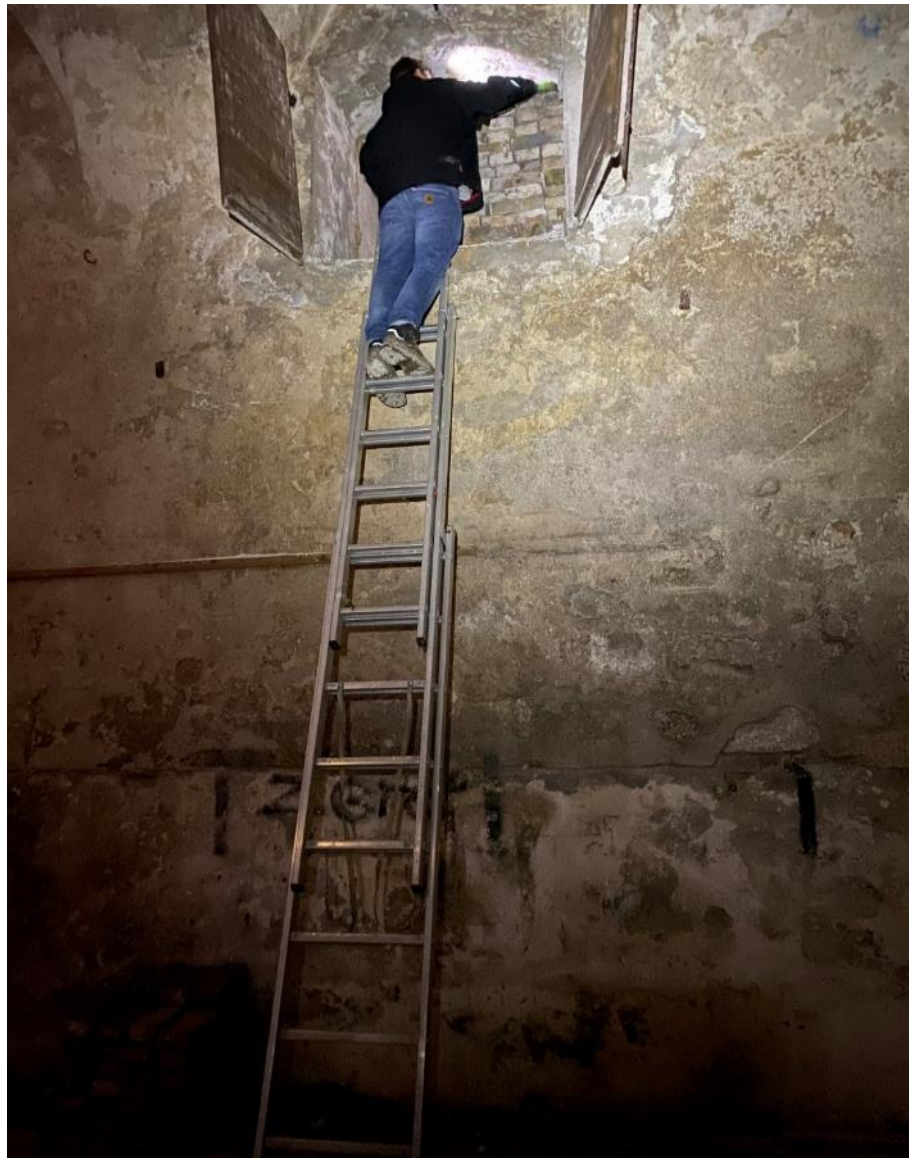
Abbildung 14: Öffnung eines zugemauerten Durchlasses.
