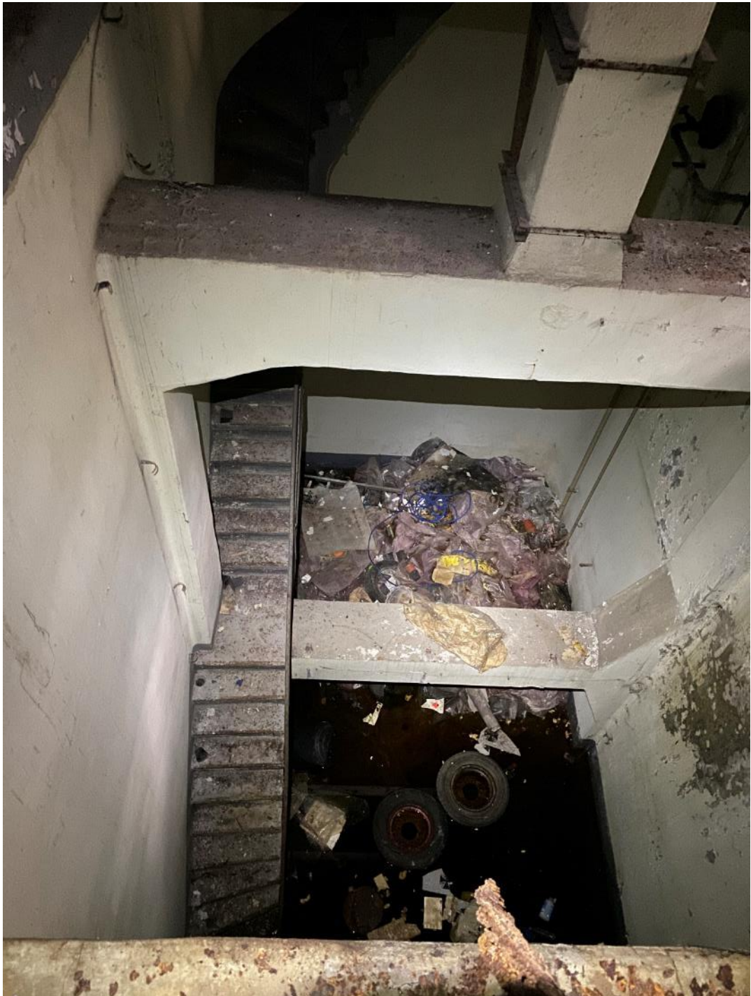
Abbildung 28: Durch Anbringen von Fledermausquartiersteinen in den Innenräumen bis nach unten können ausreichend diverse Mikroklimazonen durch die überwinternden Fledermäuse genutzt werden.
