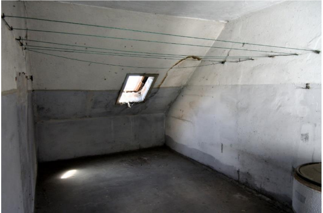
Abbildung 30: Blick in den kleinen Raum mit Fensteröffnung Richtung Nordosten.
