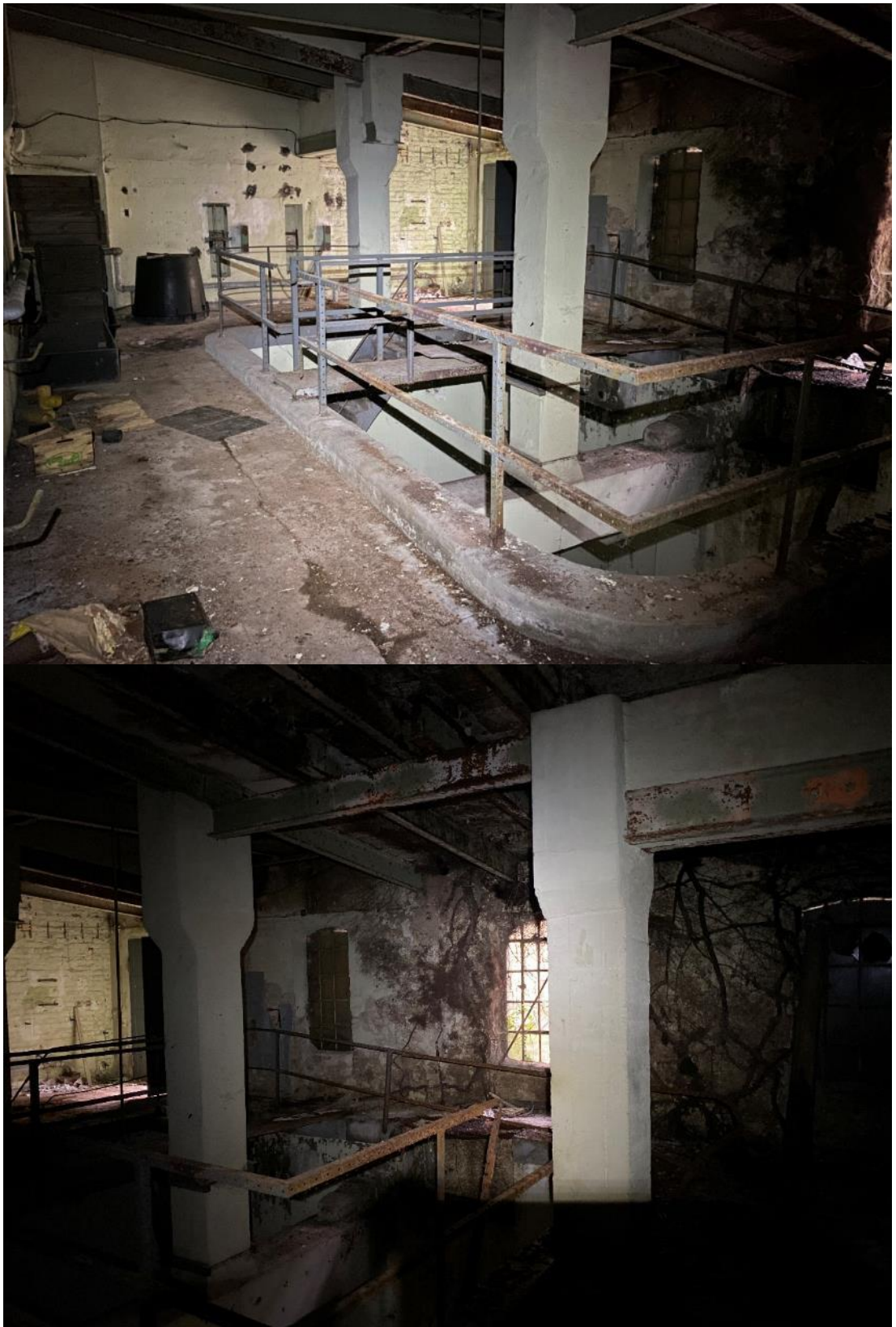
Abbildung 27: Das Erdgeschoß des Brunnengebäudes. Die alten Fenster können erhalten bleiben und dahinter eine Wand gezogen werden.
