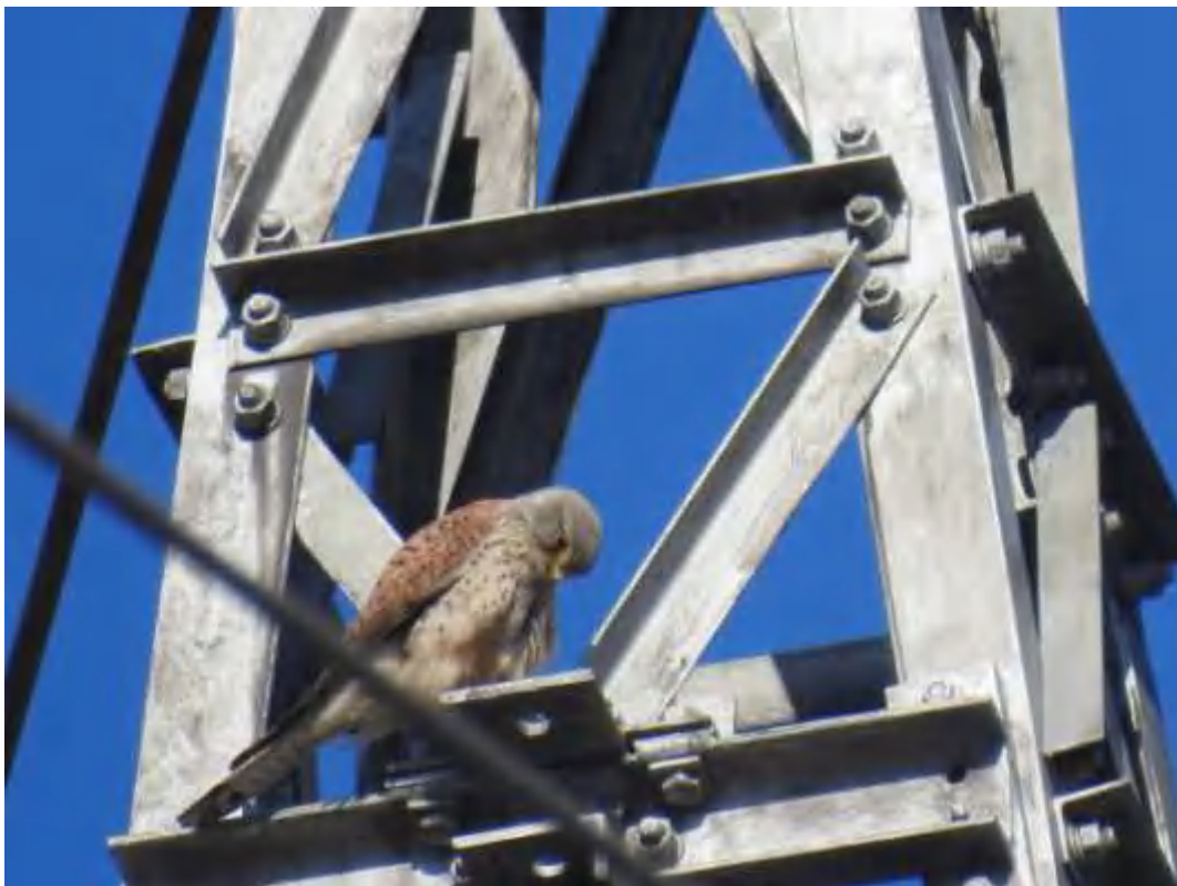
Bild 16: Der Turmfalke auf einem der Strommasten
