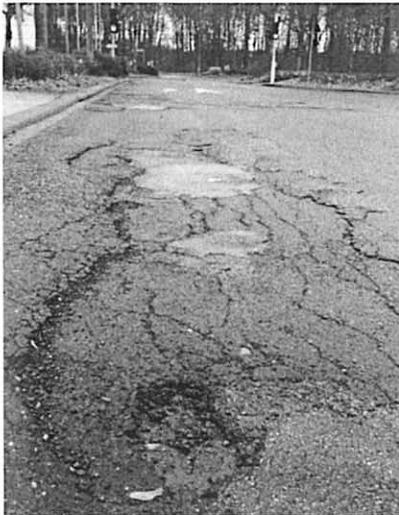
Der Fahrbahnbelag in diesem Bereich ist für Fahrradfahrer:innen in einem sicherheitsgefährdenden Zustand. Es sind inzwischen so gravierende Löcher und Unebenheiten vorhanden, dass es gefährlich ist, mit dem Fahrrad oder einem anderen Zweirad diese Stelle zu befahren. Die Asphaltlöcher müssen mittig in der Fahrbahn regelrecht umfahren werden.
