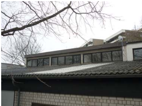
Abb. 16_Dachfläche; Ausbesserungsstellen
