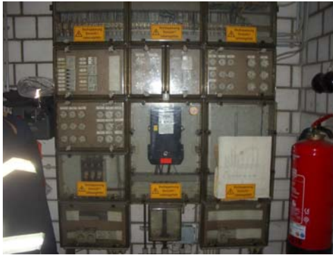
Abb. 24_Niederspannungshauptverteilung
