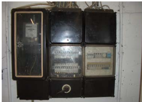
Abb. 24_Niederspannungshauptverteilung in der Fahrzeughalle
