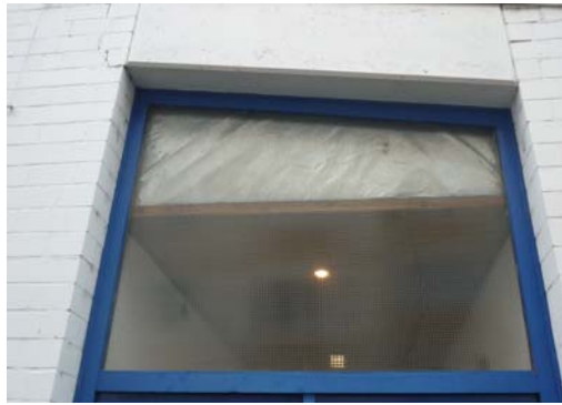
Abb. 11_nachtraglich errichtete Abhängecke aus Holzpaneelen im Fluchtweg
