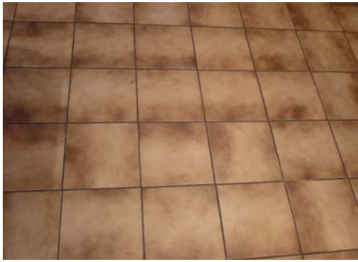
Abb. 22_ Fliesenboden im Schulungsraum
