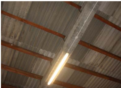
Abb. 20_Unterseite der Dachplatten
