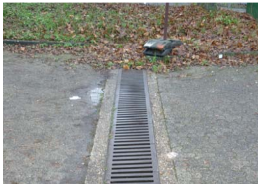
Abb. 7_Ablaufrinne als Oberflächenentwässerung des Stauraums
