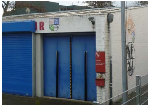
Abb. 41_Stahltor neben den modernen Einsatz-Rolltoren
