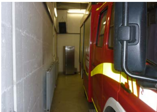
Abb. 35_zu geringer Wandabstand
