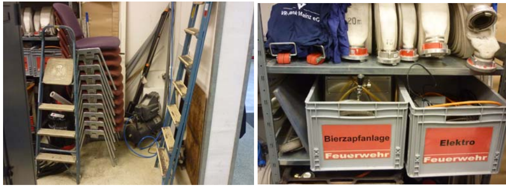
Abb. 28, 29_ Stolperfallen und Materialien des Fördervereins neben Einsatzgeräten (z.B. Schläuchen)
