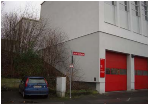
Abb. 4_ Öffentlicher Stellplatz seitlich des Gebäudes
