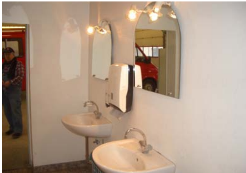
Abb. 11_Wandanstrich im Sanitärbereich
