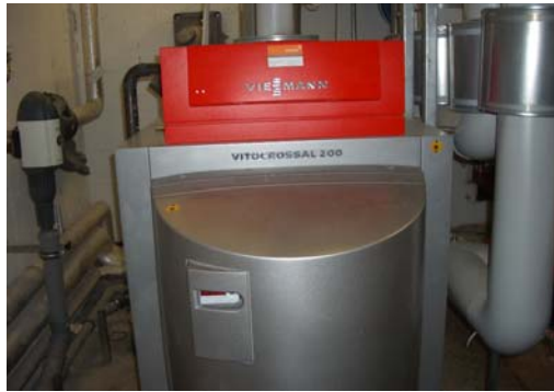
Abb. 13_Neuwertige Wärmeerzeugungskomponente
