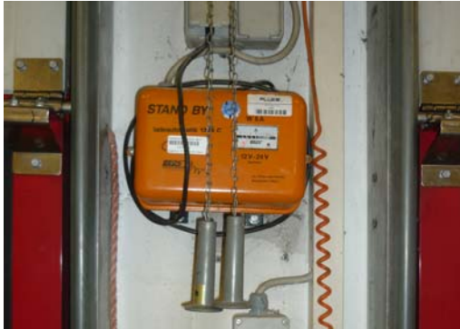
Abb. 36_Prüfintervall Rolltor, Notentriegelung
