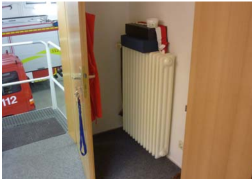
Abb. 8_Einfache Holztür zwischen Fahrzeughalle und Wehrleiterbüro
