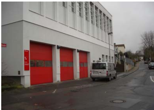
Abb. 6_Einsatz Tore führen direkt auf den öffentlichen Straßenraum
