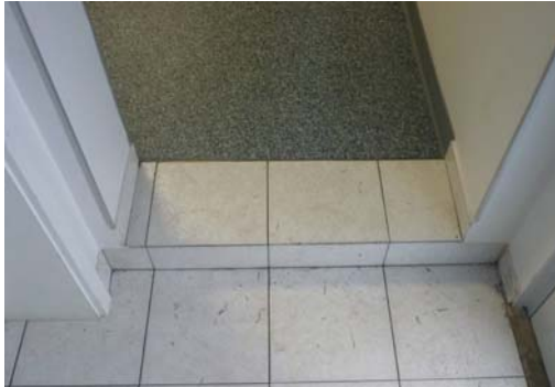
Abb. 22_Bodenbelag und Stufe im Flur zum Schulungsraum
