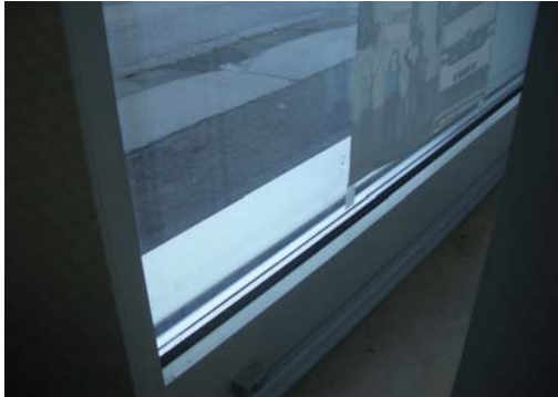
Abb. 10_dreifach verglastes Kunststofffenster des Schulungsraums
