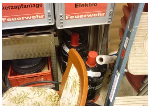
Abb. 31_Offene Lagerung von Druckgasen im Materiallager
