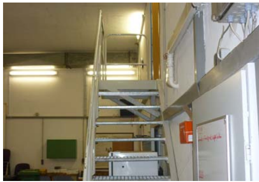
Abb. 23_Treppenaufgang zum Wehrleiterbüro
