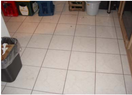
Abb. 12_ Fliesenboden in der Küche
