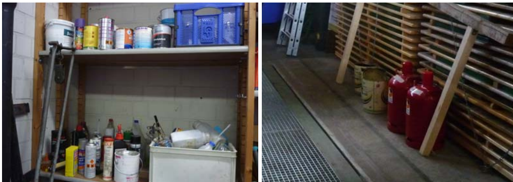
Abb. 31_Offene Lagerung von brennbaren Flüssigkeiten und Druckgasen
