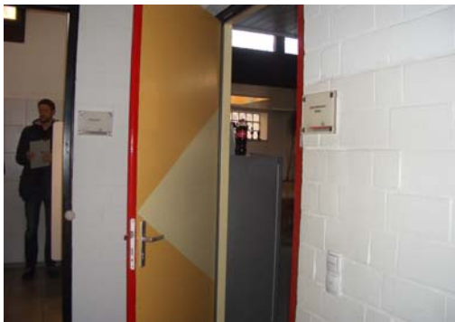
Abb. 10_Einfache Holztür zwischen Schulungsraum und Flur
