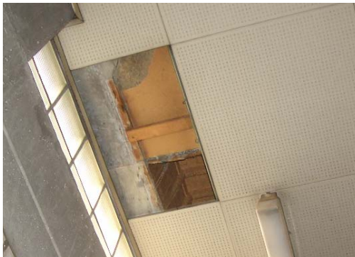
Abb. 4_Blick in das ungedämmte Flachdach der Fahrzeughalle
