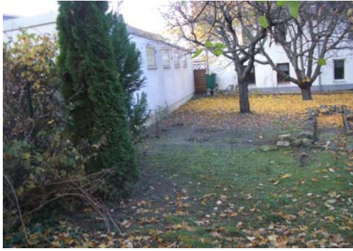
Abb. 12_Fassadenteil nur über das Nachbargrundstück zugänglich
