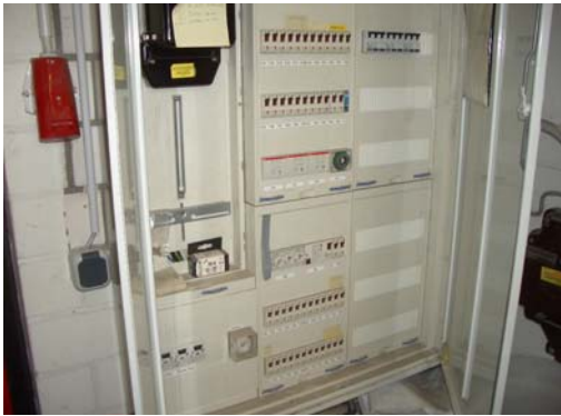
Abb. 23_Niederspannungshauptverteilung nebst Hausübergabekasten
