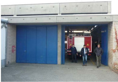
Abb. 34_ Stahltore auf der Rückseite des Gebäudes
