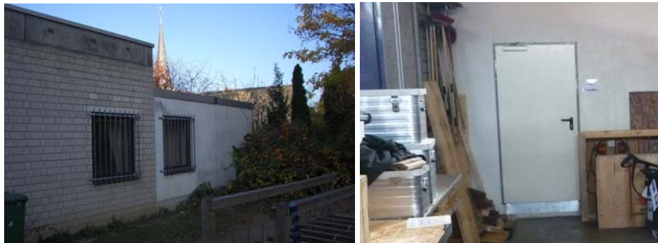
Abb. 8_Vergitterte Fenster des Schulungsraums rückwärtige Fassade
