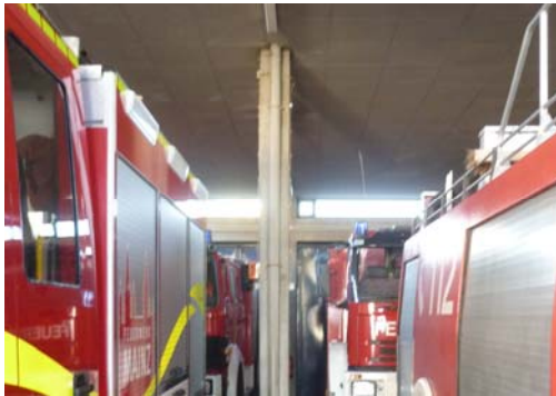
Abb. 16_Entwässerung Flachdach über Fallrohre in der Fahrzeughalle
