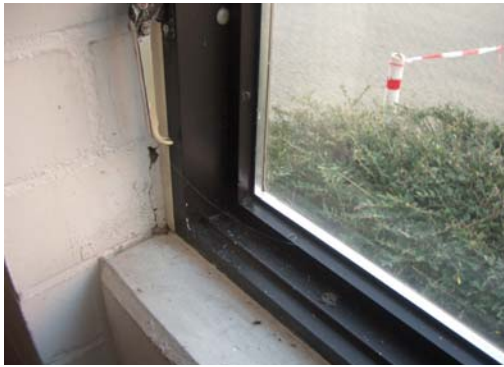
Abb. 13_Metallprofil des Fensters im Wehrführerbüro
