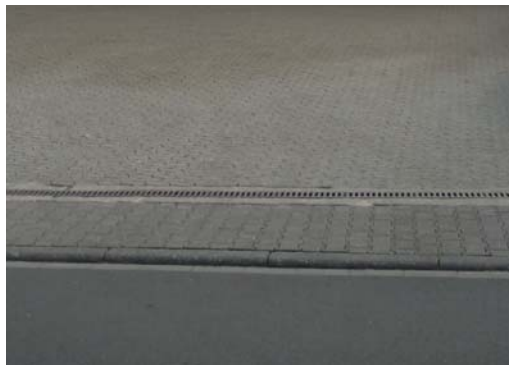
Abb. 6_Ablaufrinne als Oberflächenentwässerung des Stauraums
