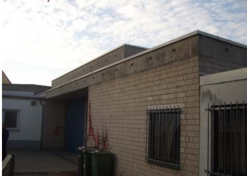
Abb. 11_Mauerwerk der rückwärtigen Fassade ohne erkennbare Schäden
