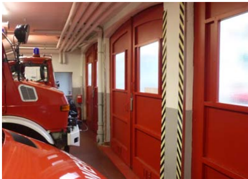
Abb. 43_zu geringe Durchfahrtsbreite mit Warnanstrich, ältere Stahltore
