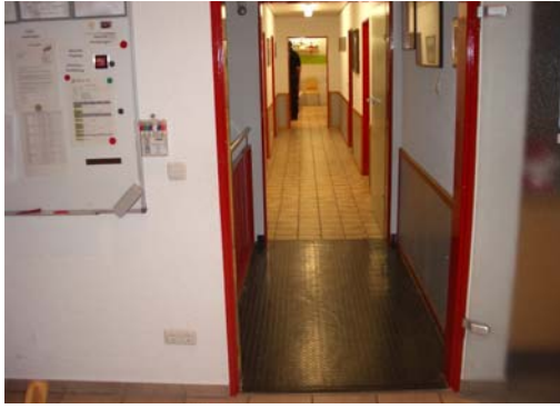
Abb. 11_Übergang Treppenraum zum Unterrichtsraum I (Glastür)
