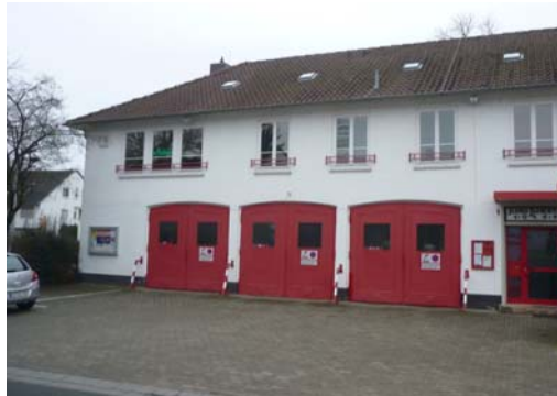
Abb. 7_Stauraum vor den Einsatz Türen
