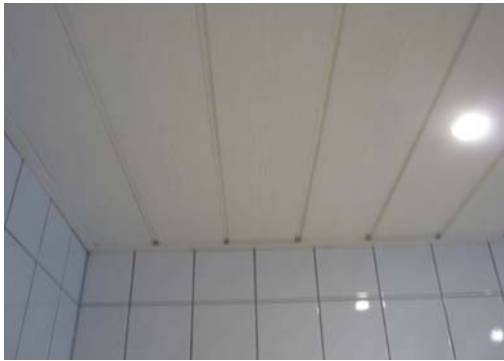
Abb. 18_Abhangdecke aus Holzpaneelen im Sanitärbereich
