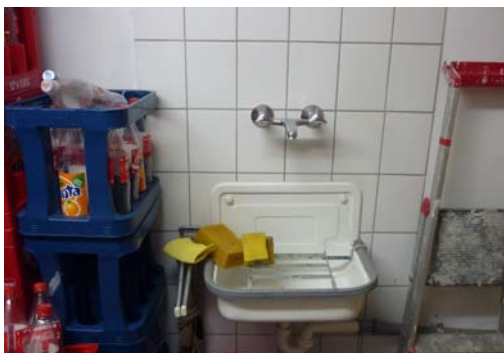
Abb. 31_Ausgussbecken im Lager / Heizungsraum.
