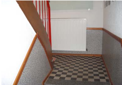
Abb. 17_Wandanstrich im Treppenhaus
