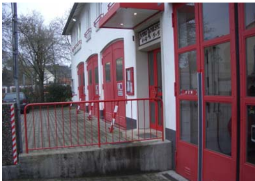
Abb. 6_ Zugang zum Gerätehaus
