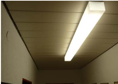
Abb. 12_Deckenverkleidung im Flur
