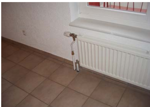
Abb. 20_ Fliesenboden im Obergeschoss
