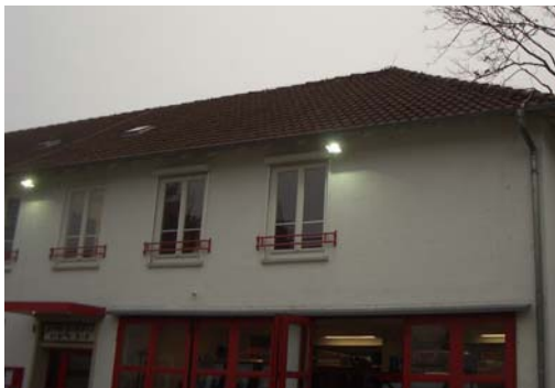
Abb. 5_ LED-Strahler beleuchten die Stellplätze, den Alarmeingang und den Stauraum
