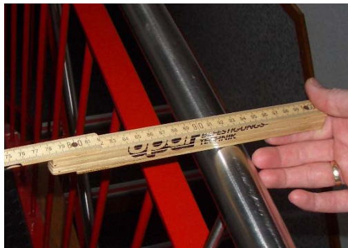
Abb. 9_Nutzbare Breite des Treppenraums von ca. 0,92 m
