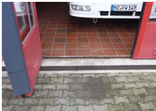
Abb. 8_Ablaufrinne der Stauraumentwässerung
