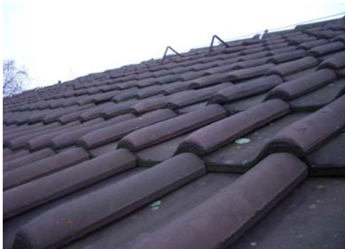
Abb. 15_ sehr leicht vermooster Dachbelag
