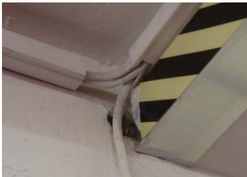
Abb. 13_nicht geschlossene Durchdringung in der Fahrzeughalle
