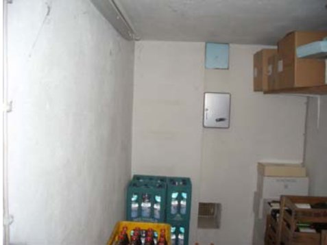
Abb. 10_Wandoberfläche im Lagerraum
