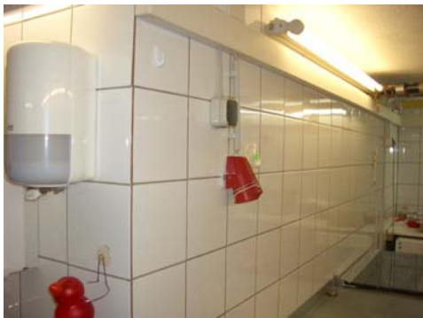
Abb 21.: Starkstromanschluß Küche
