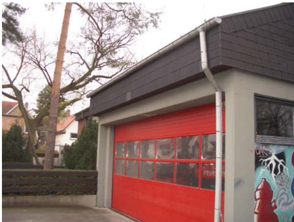
Abb. 4_Ablaufrinne vor Tor als Oberflächenentwässerung des Stauraums
