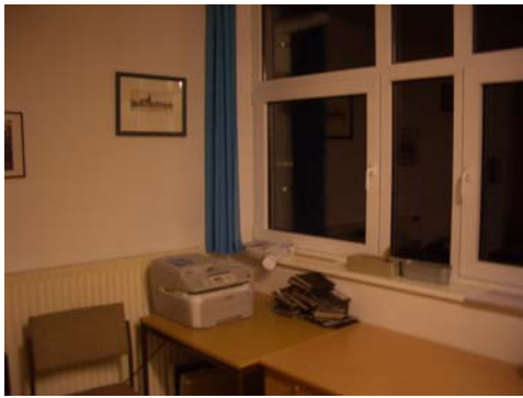
Abb. 13 Aluprofil des Fensters im Büro
