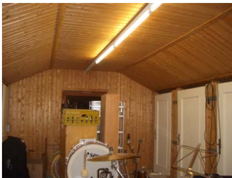
Abb. 18 Holzdecke im Proberaum
