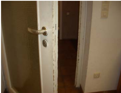
Abb. 8_Einfache Holztür zwischen Schulungsraum und Treppenhaus
