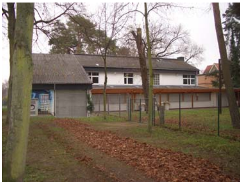
Abb. 12_Fassadenteil nur über vorgesetzte Überdachung zugänglich.
