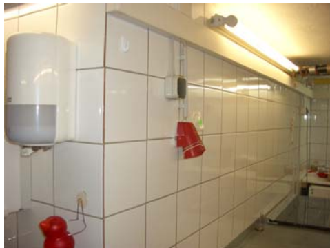
Abb 21.: Starkstromanschluß Küche
