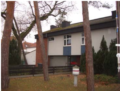
Abb. 7_ Fassade ohne erkennbare Schäden
