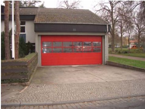
Abb. 14_Durchfahrtshöhe und Breite des Tores sind zu gering.
