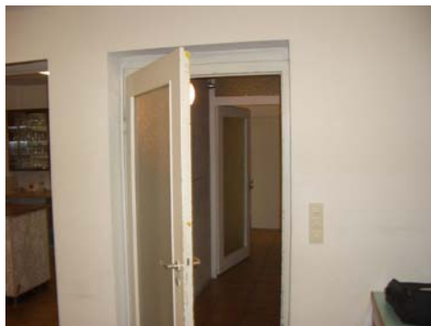
Abb. 6_Zugang zum innenliegenden Treppenhaus aus dem Versammlungsraum / Schulungsraum.
