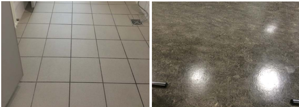
Abb. 16_ Fliesenboden im WC / Linoleumbelag im Schulungsraum 1.OG
