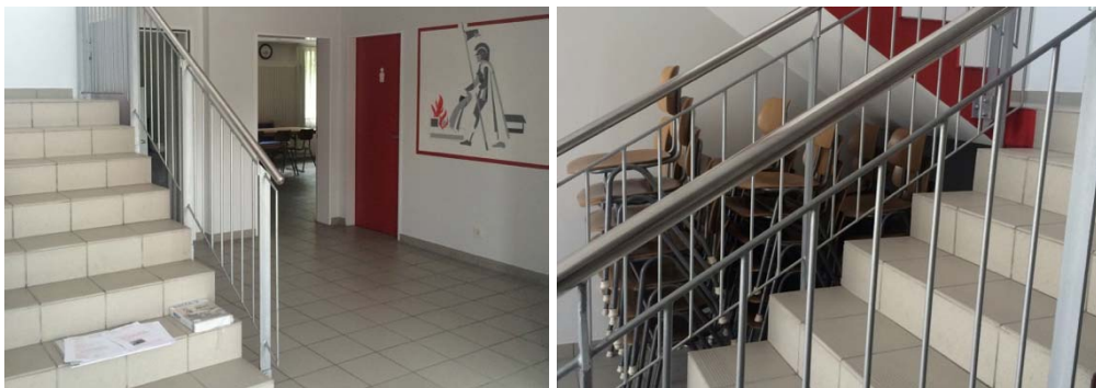
Abb. 10_Erster Flucht- und Rettungsweg über den Flur und Treppe, Brandlasten unterhalb der Treppe
