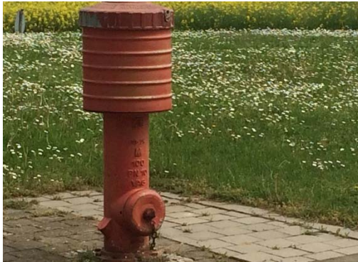
Abb. 8_Wasserhydrant seitlich neben Stauraum vor dem Sozialtrakt
