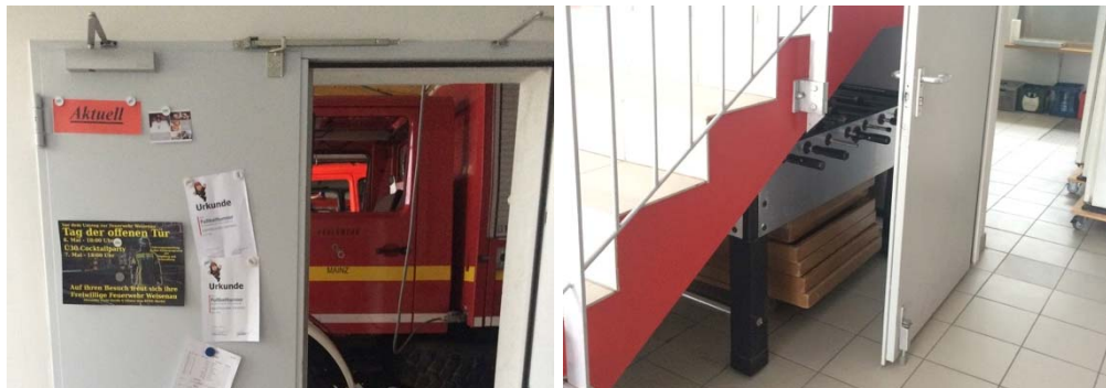
Abb. 11_T30 Tür zur Fahrzeughalle, T30 Tür zwischen Lager und Flur / Treppenraum
