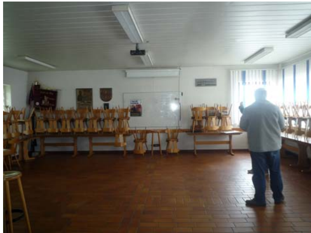
Abb. 22_ Fliesenboden im Schulungsraum
