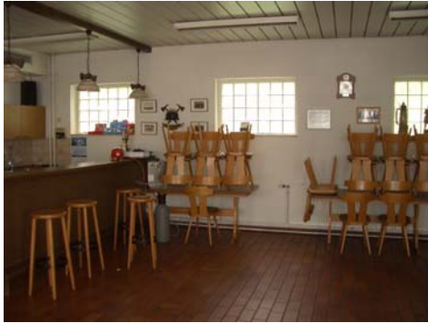
Abb. 23.1_Heizkörper im Veranstaltungs-/ Schulungsraum
