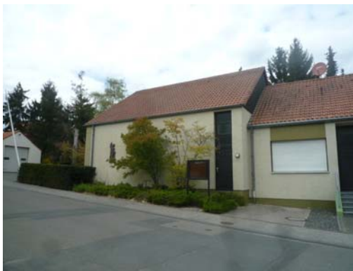
Abb. 5_ Beleuchtung der Stellplätze
