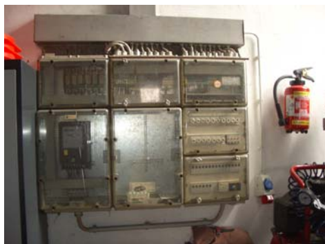
Abb. 24_Niederspannungshauptverteilung
