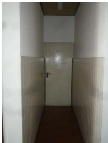
Abb. 9_ Umnutzung alter Toilettenbereich in Verbindungsflur zwischen Haupthaus und Gerätehaus
