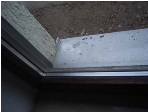
Abb. 15_dicht schließende Holzprofile
