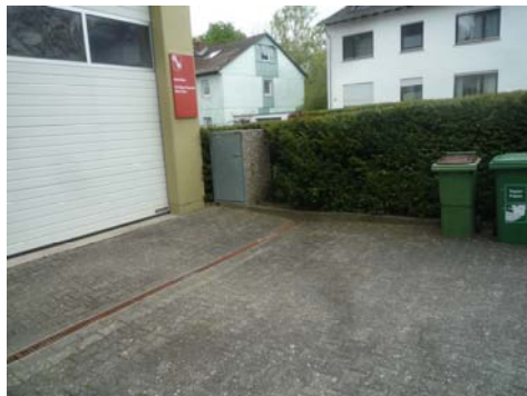
Abb. 7_Ablauf als Oberflächenentwässerung des Stauraums vor dem Gerätehaus
