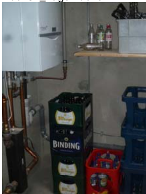
Abb. 36_Getränkelager im Heizraum
