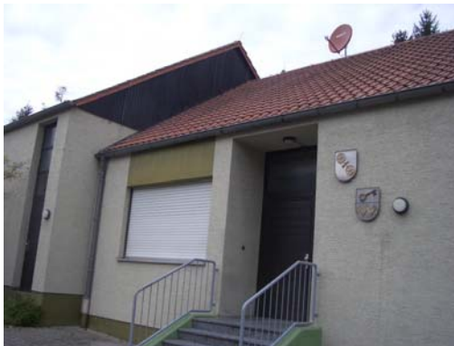
Abb. 6_Beleuchtung des Alarmeinangangs
