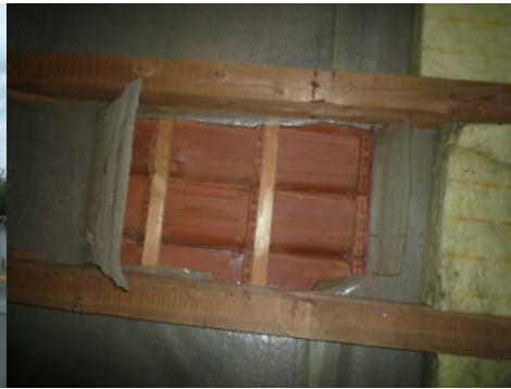
Abb. 17_Dachinnenseite/ offene Stellen der Unterspannbahn
