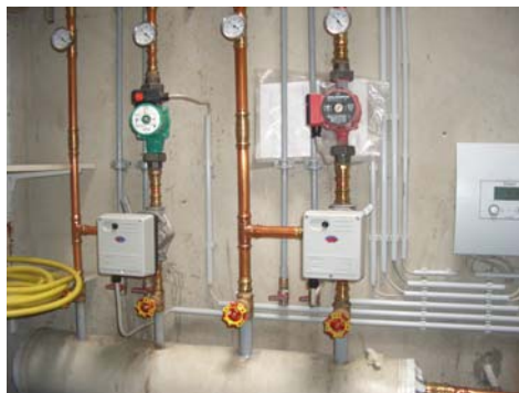
Abb. 23_Wärmeverteilnetz
