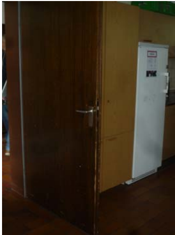
Abb. 10_Einfache Holztür zwischen Schulungsraum und Flur
