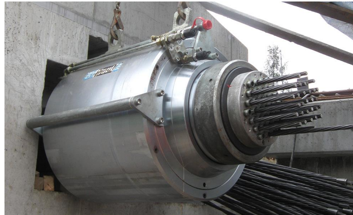
Vorrichtung zum Spannen des Spannstahls
