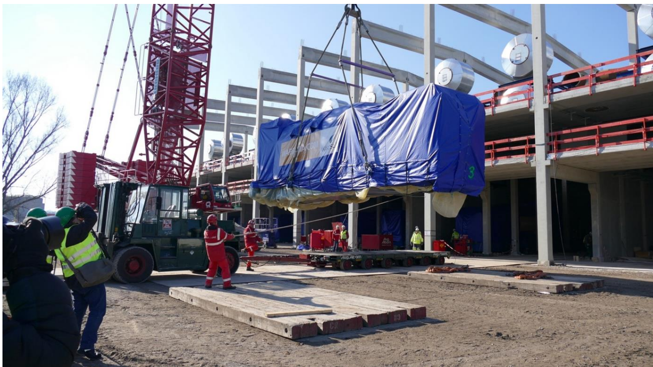
Abbildung 4: Bau des BHKWs (Quelle: KMW AG 2018)
