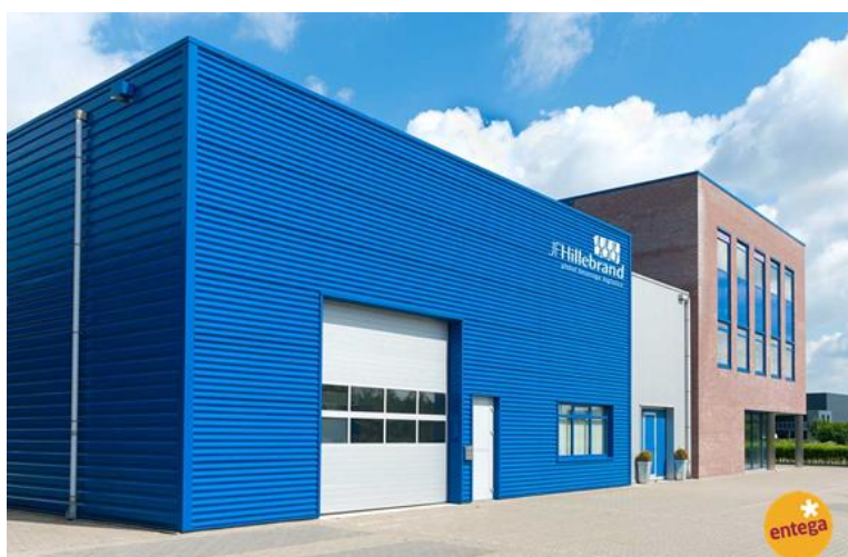
Abbildung 50: JF Hillebrand Deutschland GmbH (Quelle: ENTEKA Energie GmbH)
