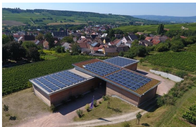
Abbildung 11: UrStrom Bürgersolaranlage auf dem Ökoweingut Huster in Großwinternheim
