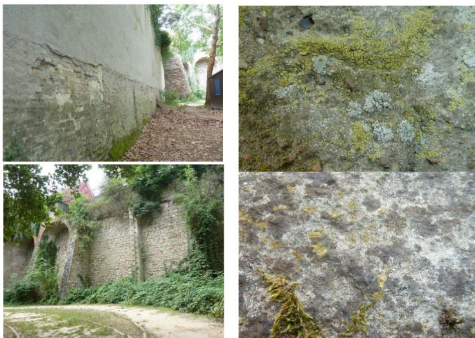
Abbildung 7: Probefläche 1 Gemäuer teils mit Mörtel.
