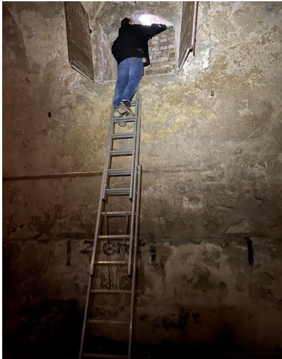
Abbildung 14: Öffnung eines zugemauerten Durchlasses.
