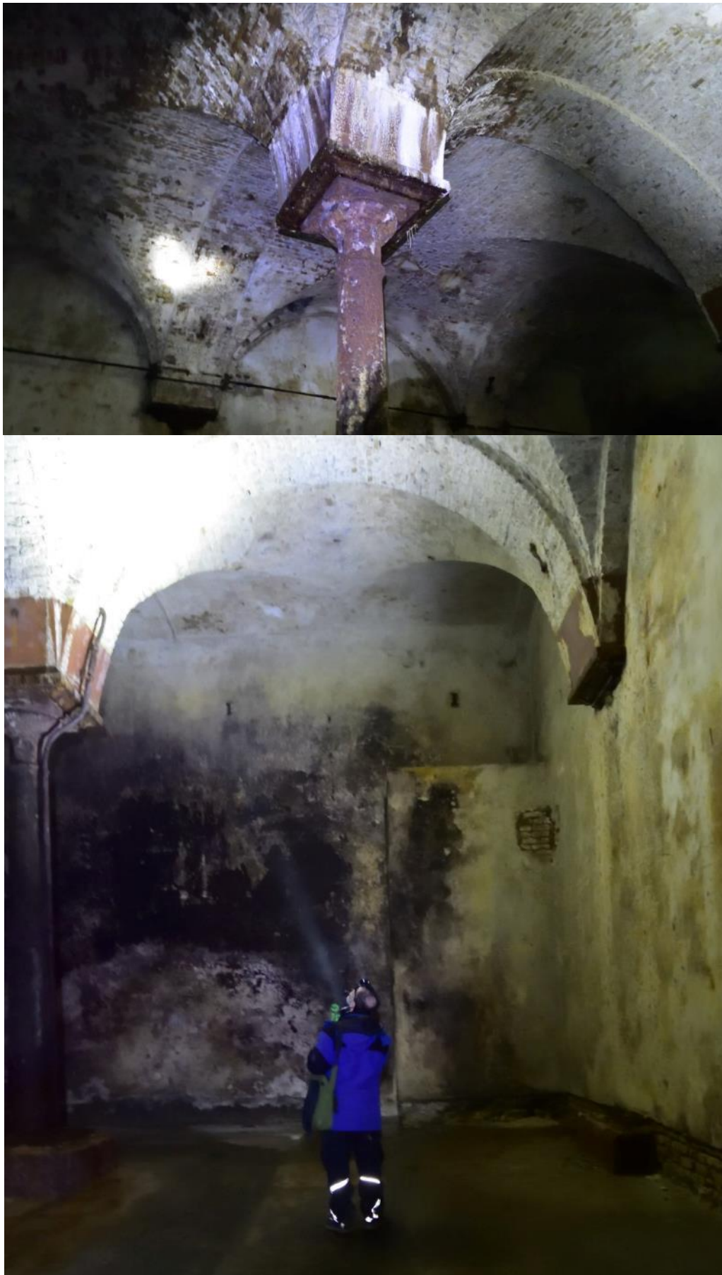
Abbildung 17: Blick in die größten Gewölbe.
