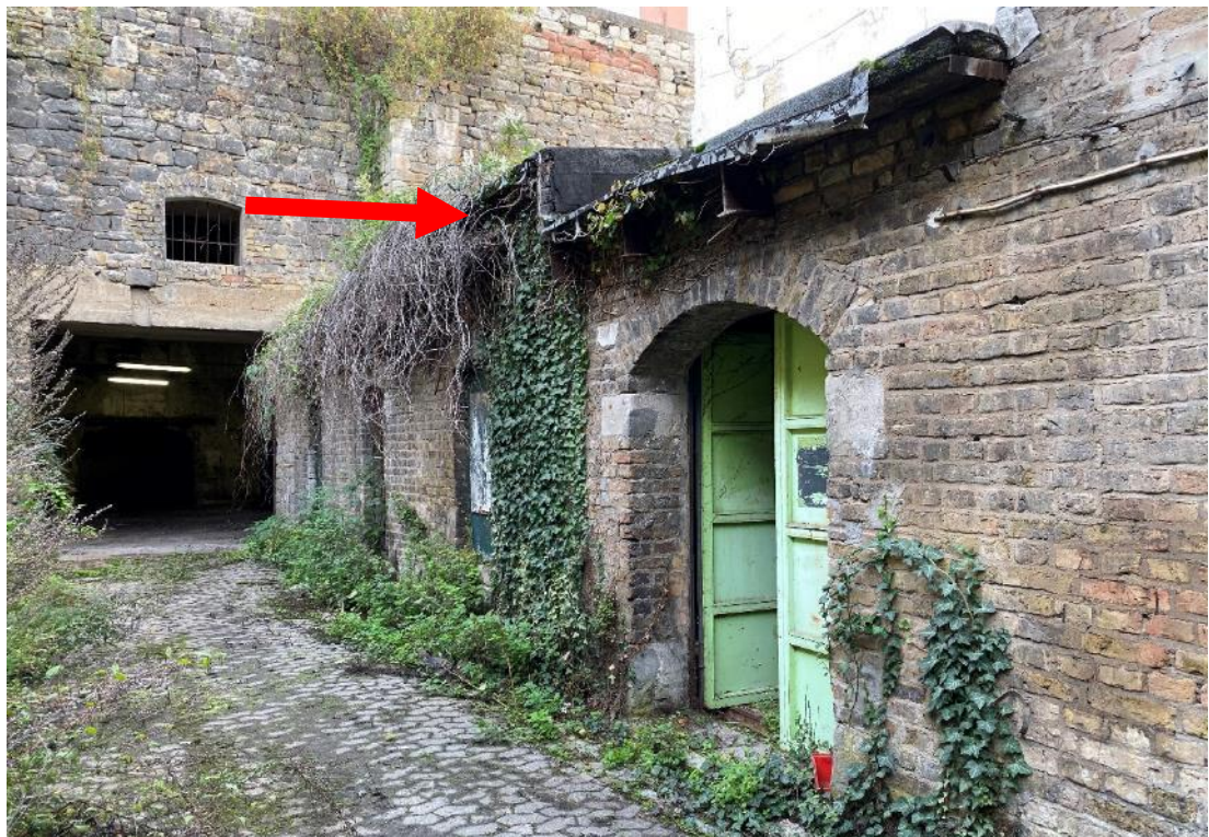
Abbildung 26: Fassade und Markierung eines zu schaffenden Einflugbereichs.
