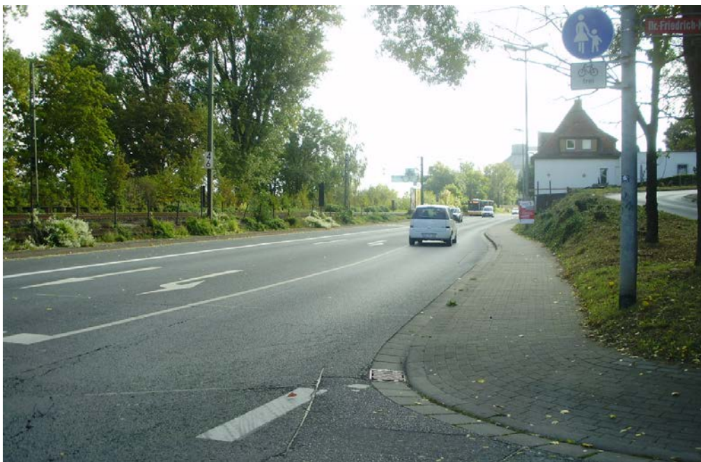
Abbildung 2.2: Fotodokumentation – Blick in die Wormser Straße nach Südosten
