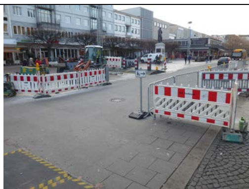
Abbildung 10: Notfallmaßnahme am Gutenbergplatz 30
