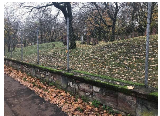
Sockeldetail / Mombacher Straße (Foto 10, Dr. Nessel)
