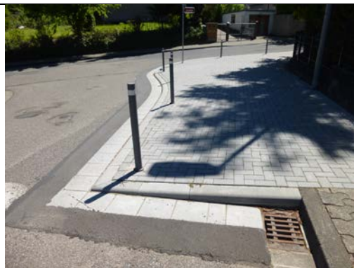
Abbildung 8: Verbreiterung der Gehwege für sichere Schulwege 28
