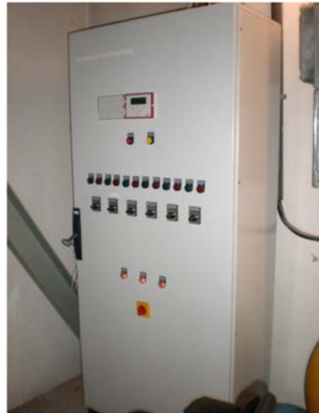
Abbildung 2: Schaltschrank für GA von außen
