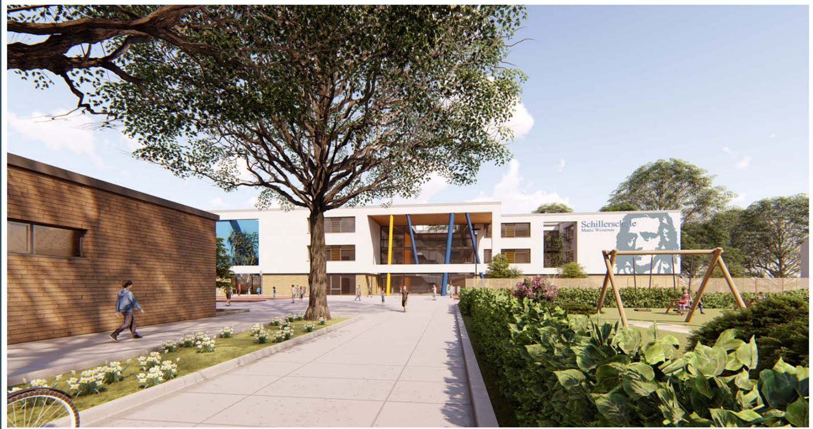
GRUNDSCHULE SCHILLERSCHULE STADTVERWALTUNG MAINZ
