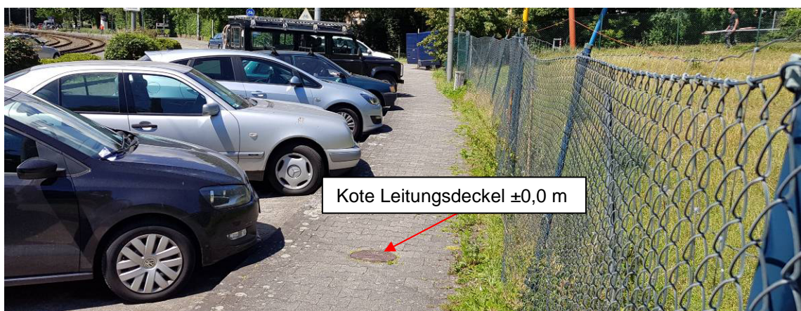
Foto 1: Leitungsdeckel als Bezugshöhe \pm 0,0 m
