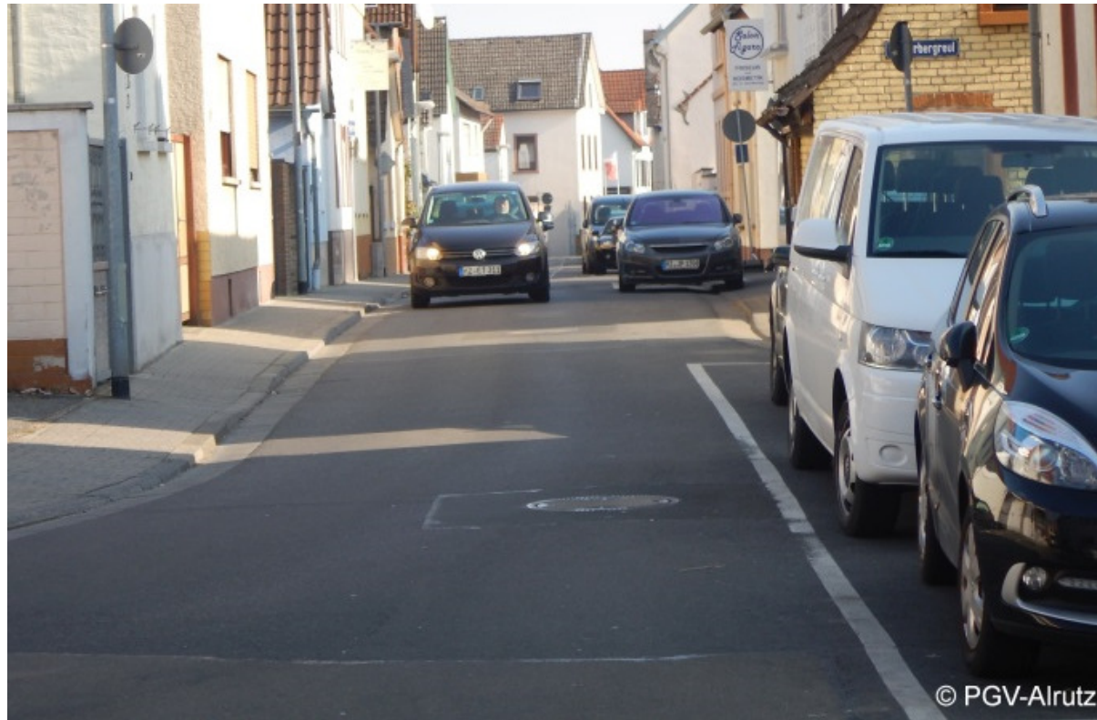
Grabenstraße zw. Budenheimer Straße und Koblenzer Straße
