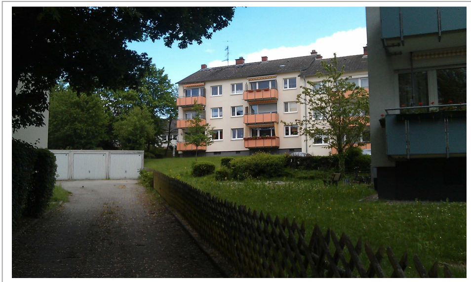
Foto 9: Zeilenbebauung im Süden des Plangebiets
