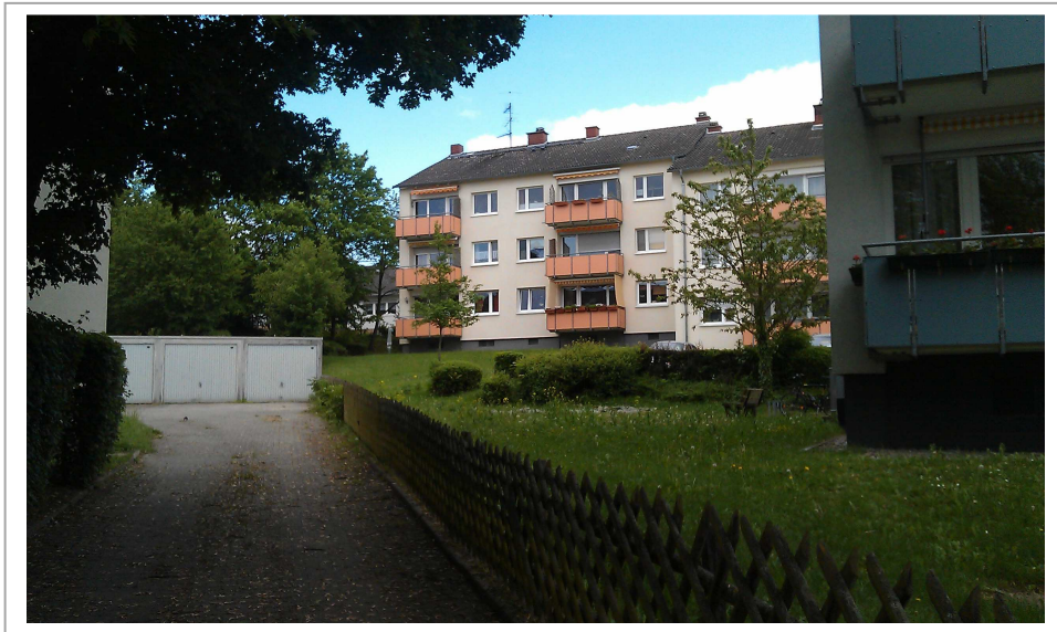
Foto 9: Zeilenbebauung im Süden des Plangebiets
