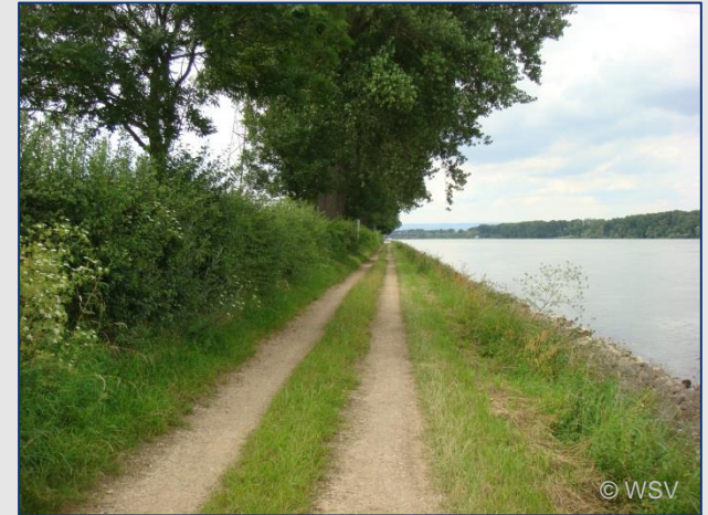
▶▶ Uferparalleler Betriebsweg mit Hybridpappeln unmittelbar am Ufer
