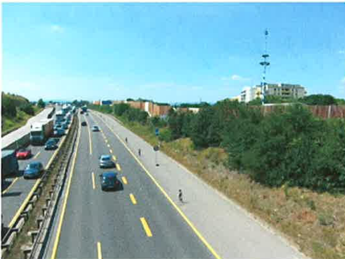
A60 in Höhe des Baugrundstücks - Fahrtrichtung Bingen - mit Lärmschutzwand (07.07.2010)
