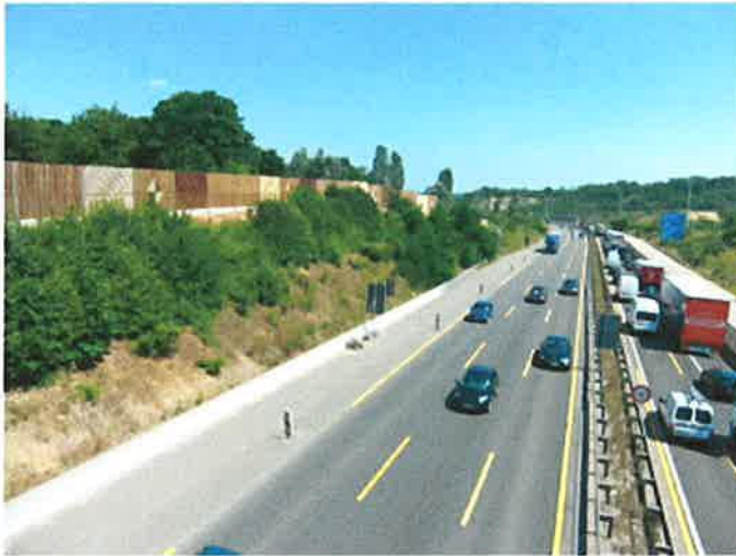
A60 in Höhe de Baugrundstücks - Fahrtrichtung Rüsselsheim - mit Lärmschutzwand (07.07.2010)
