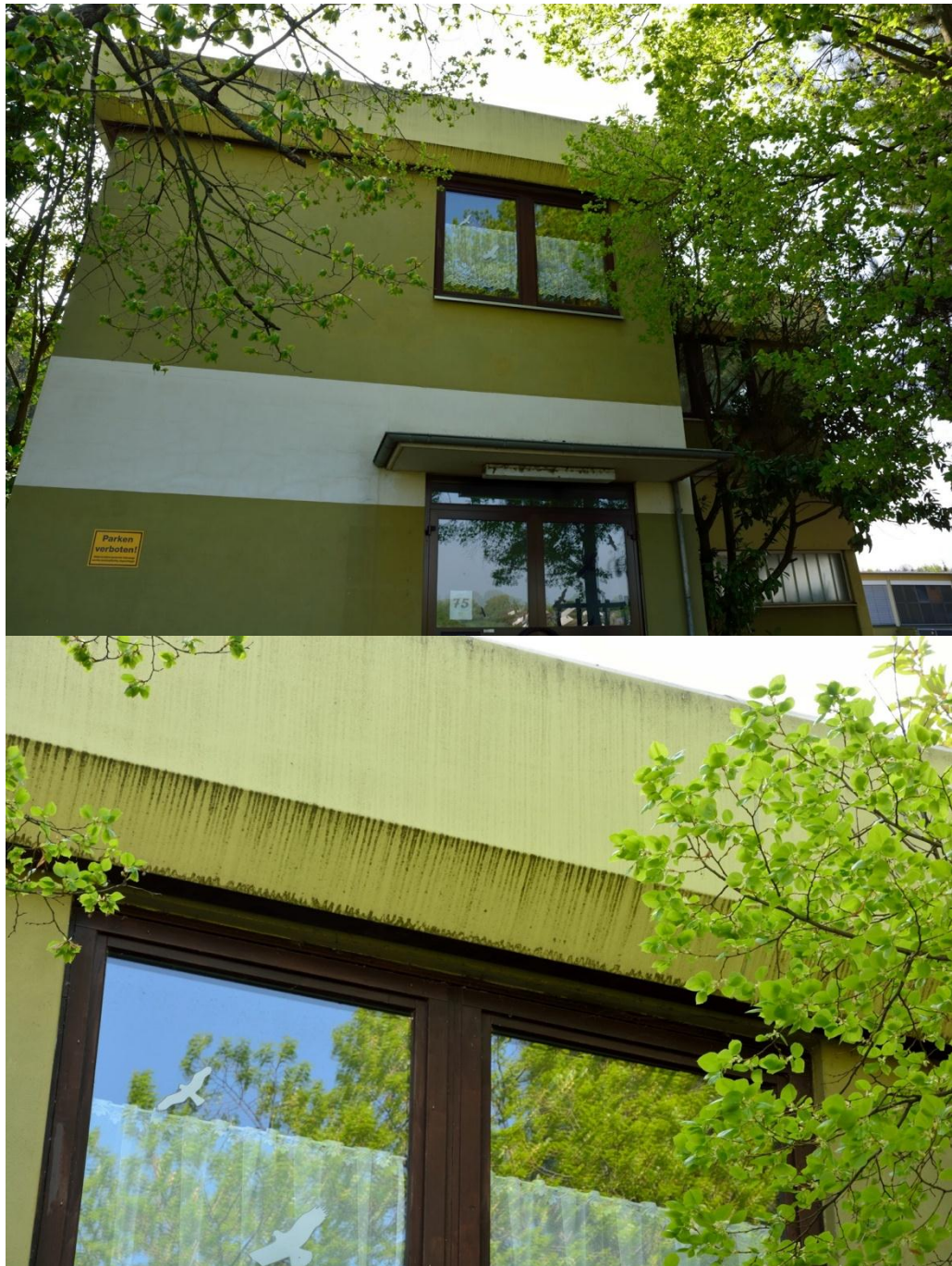
Betriebsgebäude der alten Druckerei
