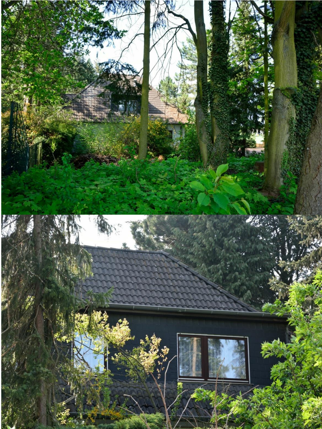
Baumbestand und Wohngebäude im Süden.
