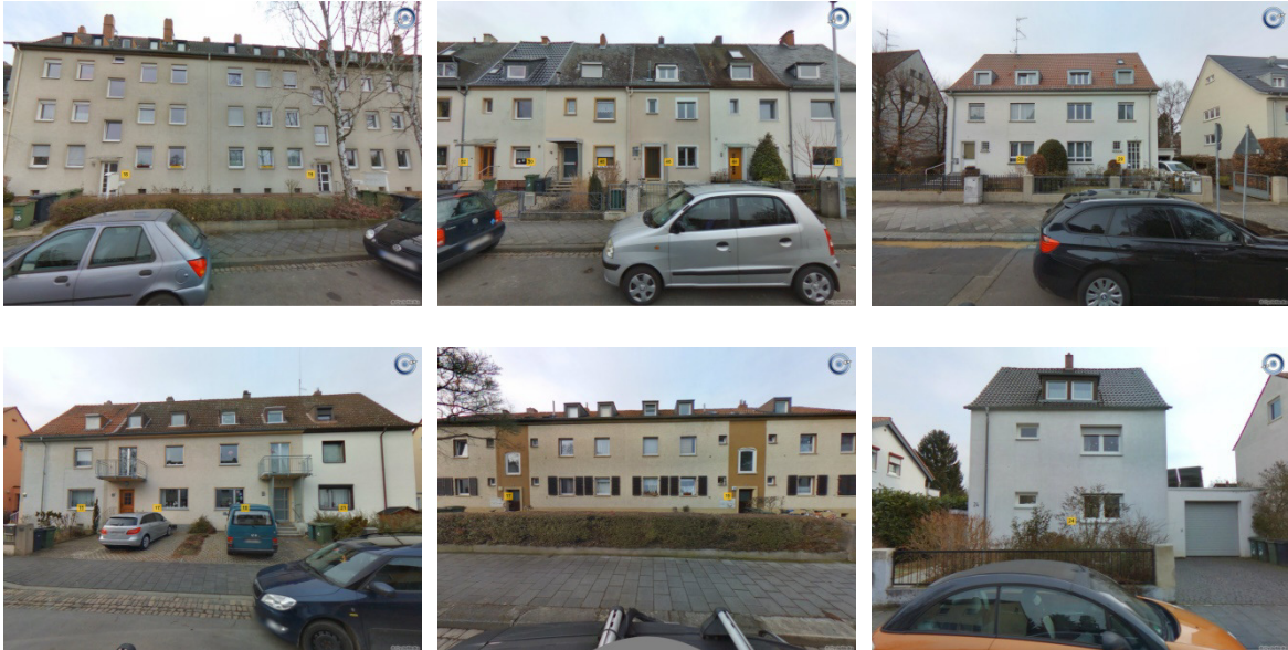
Abb.: Beispielfotos „Dachaufbauten Friedrich-Ebert-Siedlung“; ©cyclomedia
