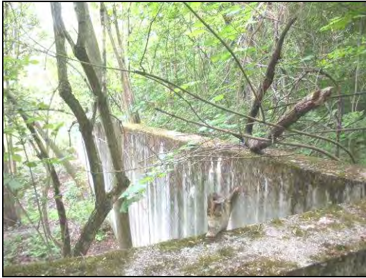
Betonmauer zw. ND/ LSG und Sporthalle
