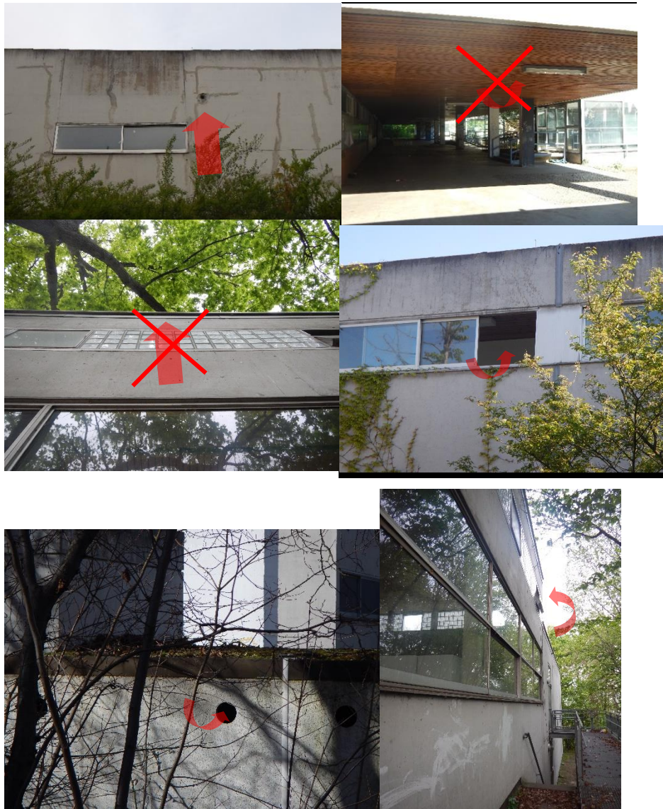
Abbildung 7: Ansichten der Schulgebäude (inkl. Garagen und Sporthalle) (rote Pfeile: Beispiele von quartierbietenden Strukturen bzw. potenziellen Einschluflmöglichkeiten für z.B. Gebäudebrüter oder Fledermäuse, rote durchgestrichene Pfeile haben hier kein Potenzial vgl. Ergebnistext) [Fotos: N. Zeuner (Fa. BG Natur)].
