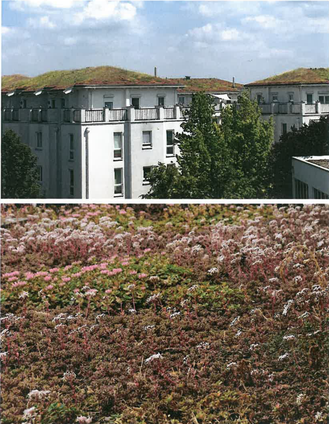
Abbildung 14: Beispiel einer Dachbegrünung (Wohngebiet Wiesbaden Erbenheim sowie Detailansicht Garagenbegrünung Nackenheim) [Fotos J. Tauchert (Fa. BG Natur), 2016].
