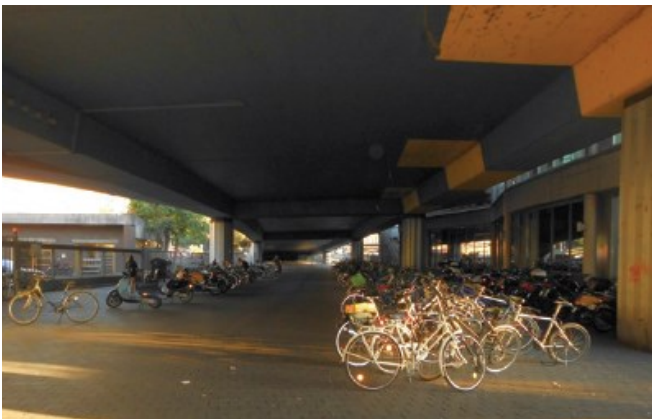
Abb. 2: aktuelle Situation unter der Hochbrücke am Hauptbahnhof West
