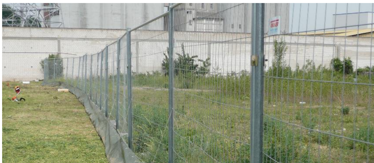
Abbildung 13: Beispiel Kombination aus Reptilienzaun und Bauzaun (Achtung: hier nicht blickdicht, wie projektbezogen erforderlich!) [Fotos J. Tauchert (Fa. BG Natur), 2016].
