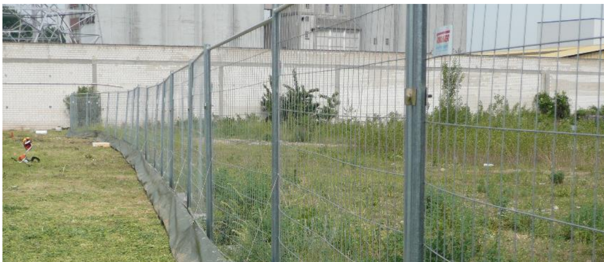
Abbildung 13: Beispiel Kombination aus Reptilienzaun und Bauzaun (Achtung: hier nicht blickdicht, wie projektbezogen erforderlich!) [Fotos J. Tauchert (Fa. BG Natur), 2016].
