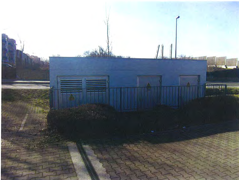
Bild 8: Blick auf das Transformatorengebäude. Dieses befindet sich im Eigentum der Stadtwerke Mainz Netze GmbH.
