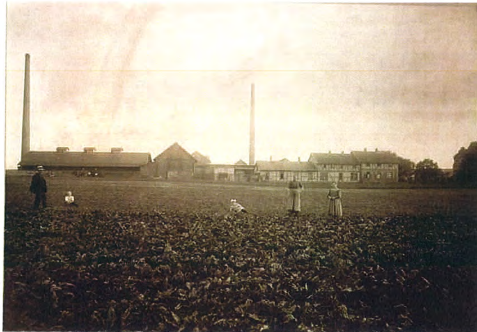
Bild 17: Blick auf die Ziegelei von Norden aus (heutige BAB 60). Links das Gebäude mit Ringofen I / Kamin I. Bildmitte und rechts Lager-, Sozial- und Wohngebäude.
