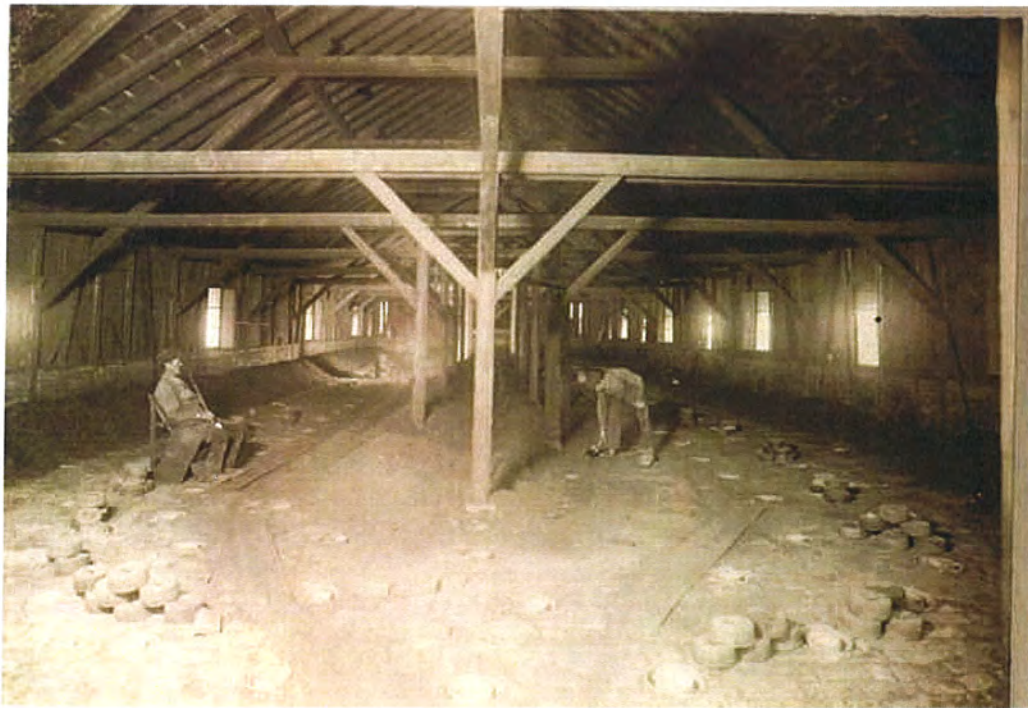
Bild 15: Die Beschickung des Ringofens wurde von oben aus durchgeführt.
