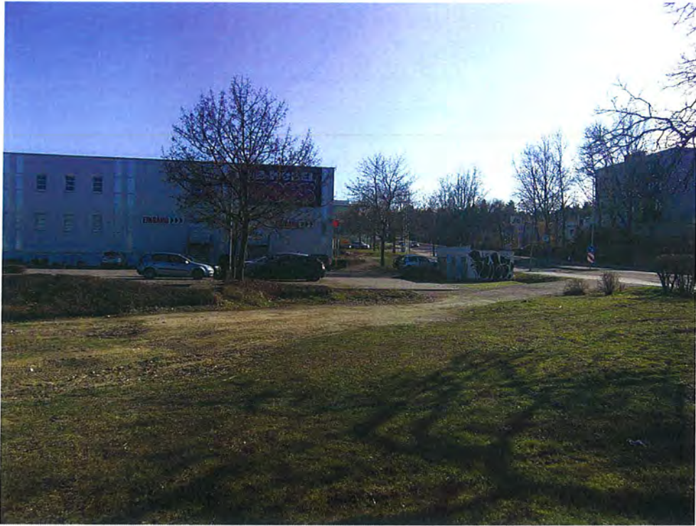
Bild 1: Blick von Nordwesten auf die Untersuchungsfläche. Im Vordergrund Grünfläche mit provisorischer Zufahrt. Die aktuelle GOK der Grünfläche entspricht voraussichtlich der GOK der ehemaligen Ziegelei Aloys Richardt. Im Hintergrund Parkplatz und Hauptgebäude. Rechts die Trafostation.
