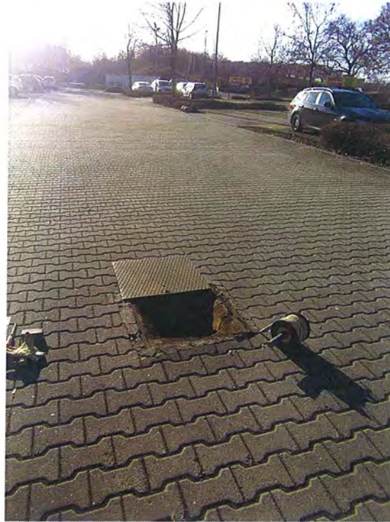
Bild 9: Blick auf die Abdeckung des ehemaligen Betriebsbrunnens. Der Betriebsbrunnen befindet sich im Fahrbereich des Parkplatzes.
