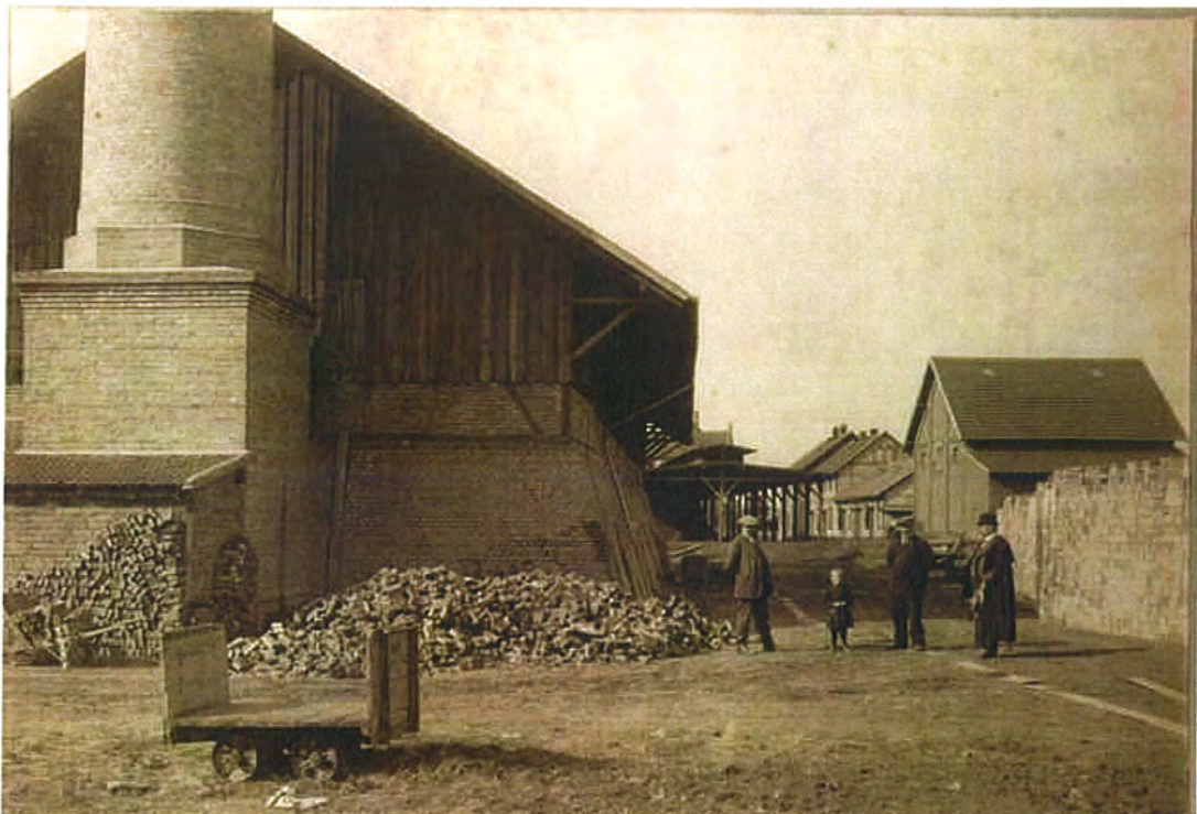
Bild 14: Gebäude mit Ringofen I / Kamin I
