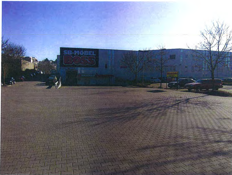
Bild 3: Blick von der Nordostecke der Untersuchungsfläche auf den Parkplatz und das Hauptgebäude. Links die Hauptzufahrt zur Alten Mainzer Straße. Das Gelände steigt nach Süden um etwa 2 – 2,5 m an.
