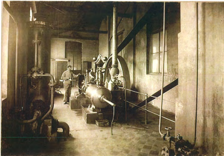
Bild 20: Dampfmaschine. Diese befand sich im Maschinengebäude. Mittels Transmissionsriemen wurde die weiteren Maschinen angetrieben.
