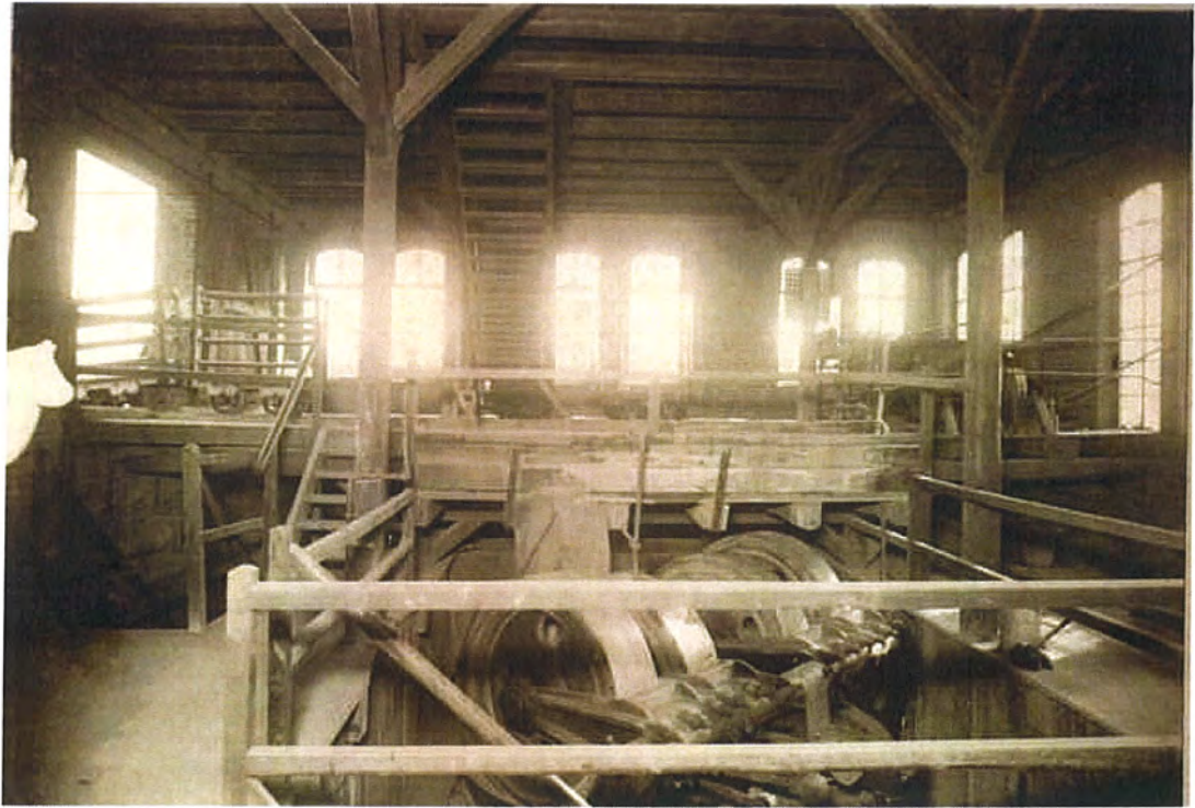
Bild 13: 1. OG des Maschinengebäudes. Links der Holzsteg über den der Rohstoff mittels Loren zugeführt wurde.
