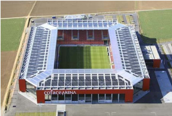
Abbildung 29 PV-Dachanlage auf der OPEL ARENA (ehemals Coface Arena) Quelle: [Juwi 2016]
