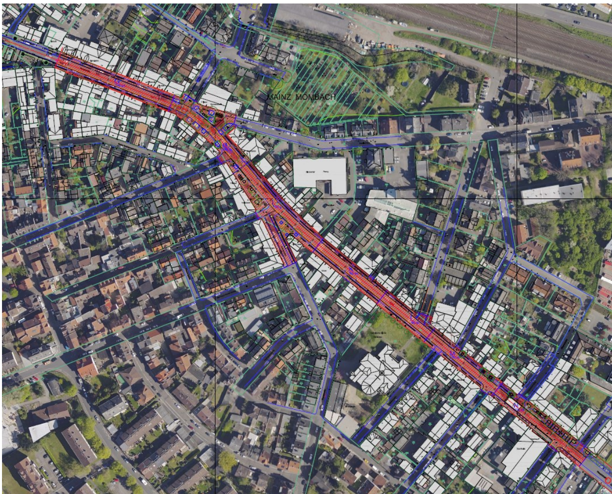
Bereich 3. Bauabschnitt (Luftbild 2016)
