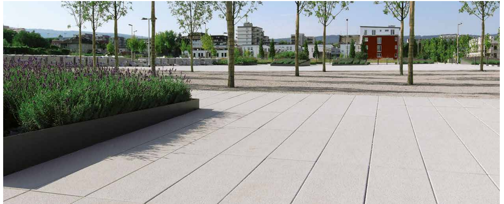
Großformatige Betonplatten auf den Platzflächen und Promenaden
