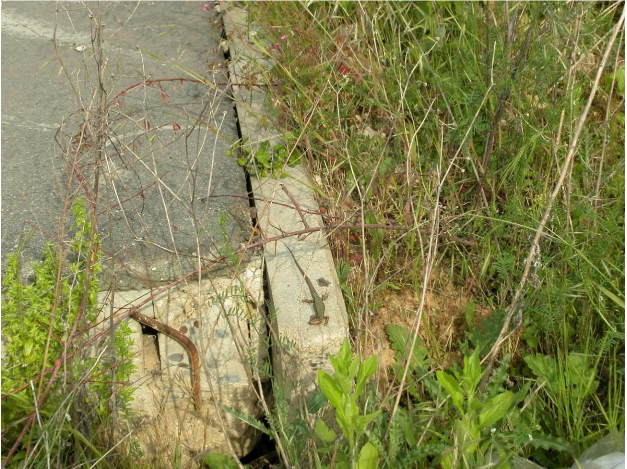
Abbildung 16: Mit Mauereidechse besiedelte Mauerspalte (Fundamentreste) im südöstlichen Gebietsteil.
