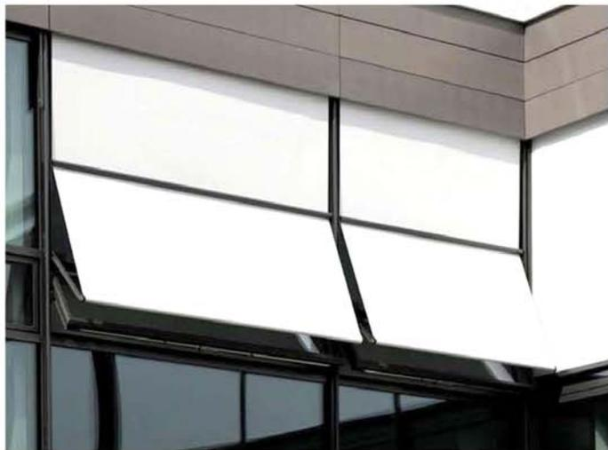
Oben: Raffstorekasten in Fassade eingeputzt
