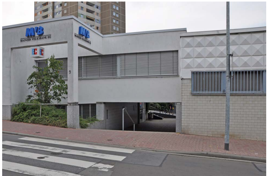
Westlicher Zugang / Unterführung Hindemithstraße
