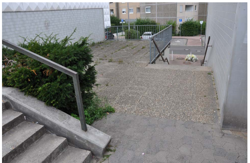
Östlicher Zugang zur Regerstraße
