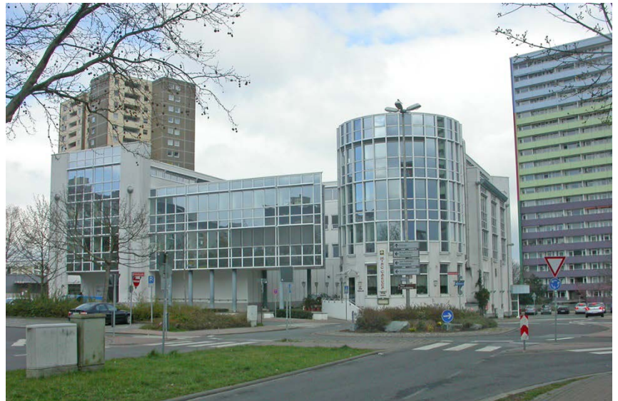
Fassade nördliche Brucknerstraße
