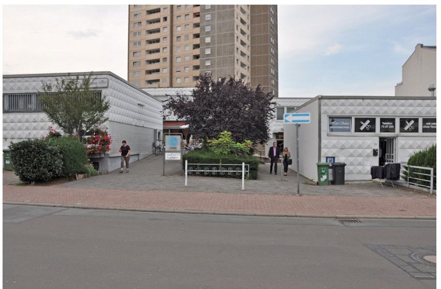
Zugang mittig Hindemithstraße
