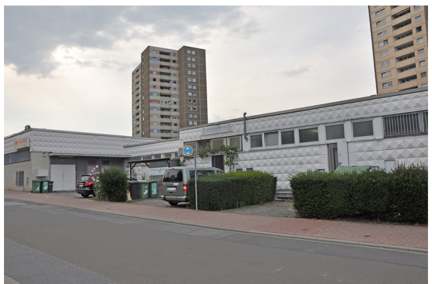
Ansicht Hindemithstraße Richtung Nord- Westen
