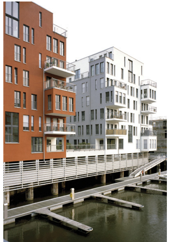
Quelle: Grundstücksgesellschaft Westhafen GmbH, Frankfurt
