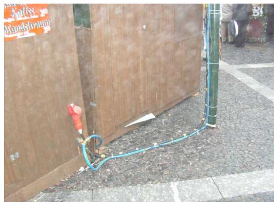
Abb.16: Unverdecktes Stromkabel
