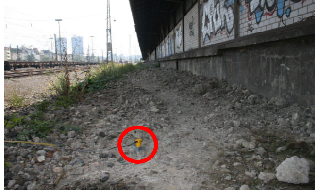
Messposition 1: 9,5 m von 1. Gleis
