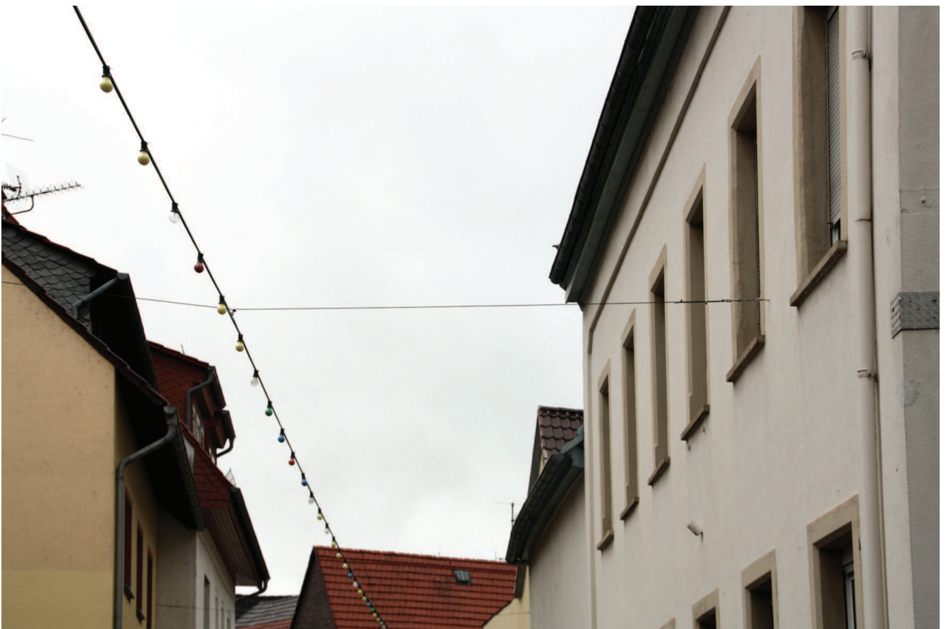
Bestand Lichterketten und Seilabspannungen_Mainz-Hechtsheim
